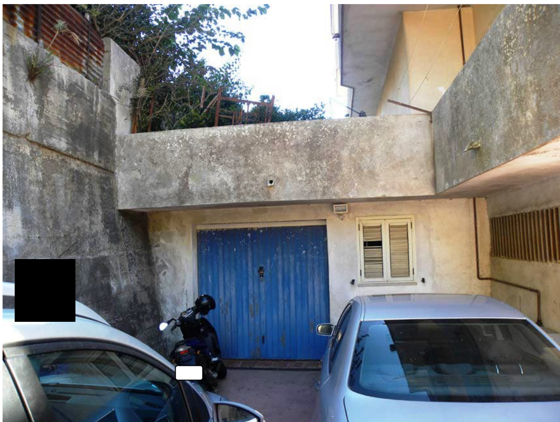
Foto n. 4: Vista esterna del locale garage facente parte dell'unità immobiliare oggetto di pignoramento (vista dalla corte comune)
