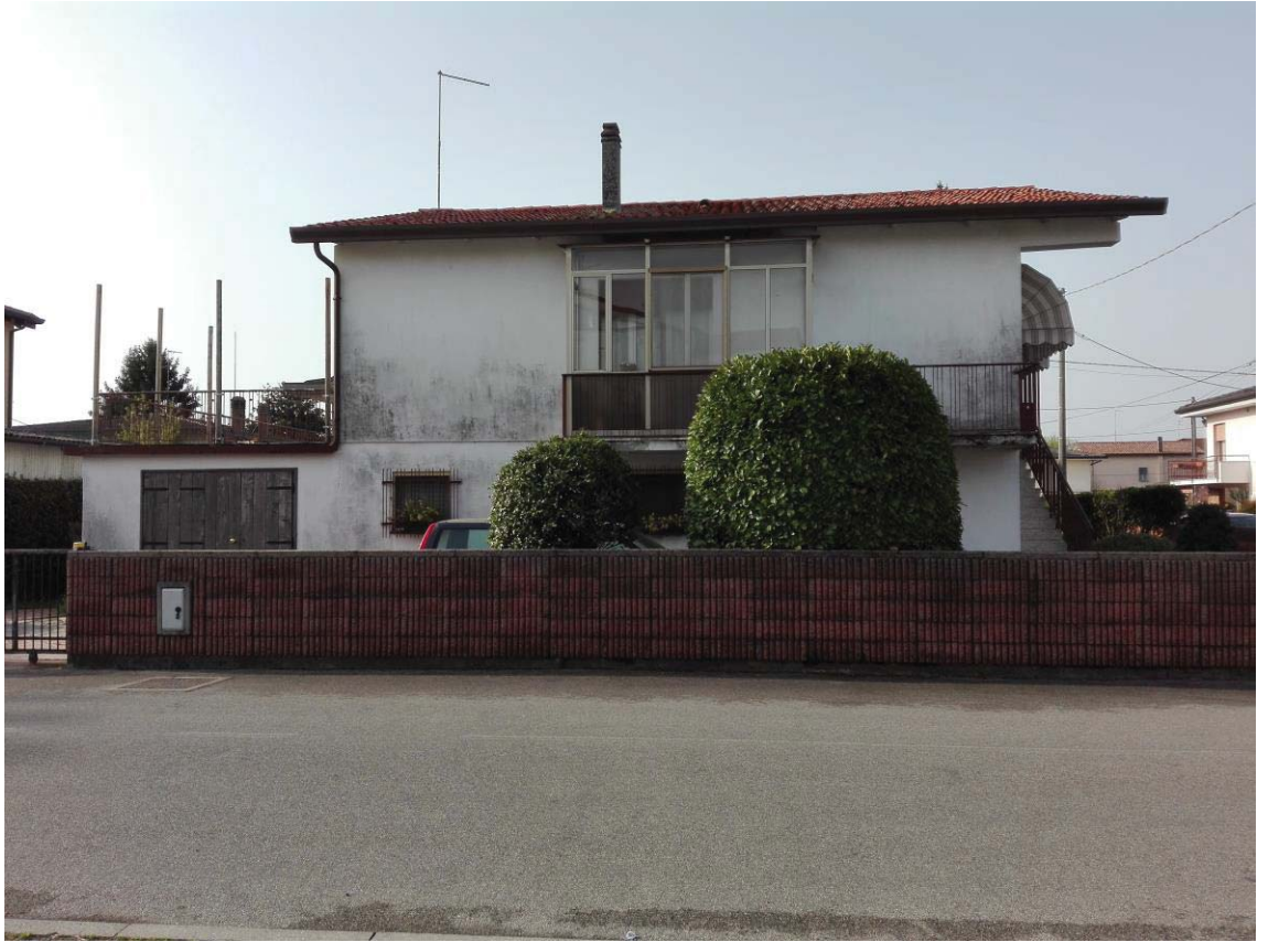
FOTO 4 IMMOBILE LATO NORD SU VIA BARACCA
