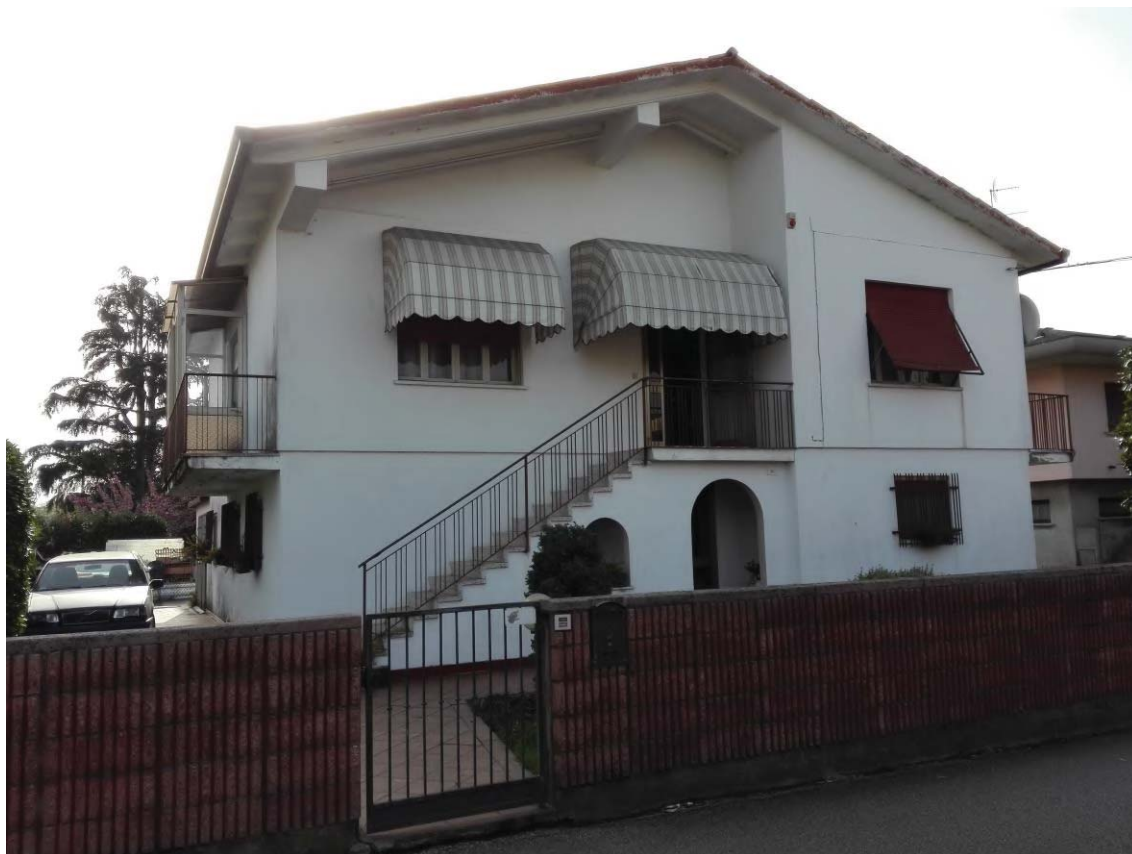
FOTO 2 ACCESSO PEDONALE VIA BERGAMO
