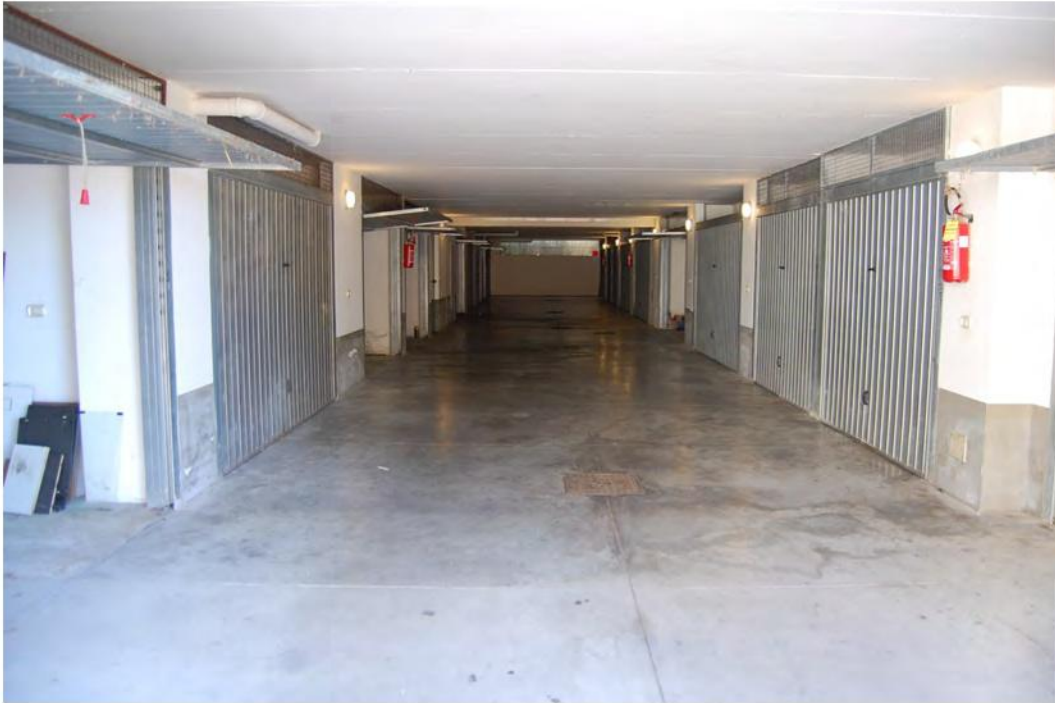
Foto n. 7 – Corsia garages – Piano interrato
