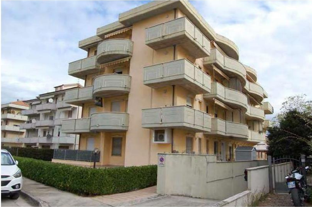
Foto n. 1 – Vista esterna palazzina
