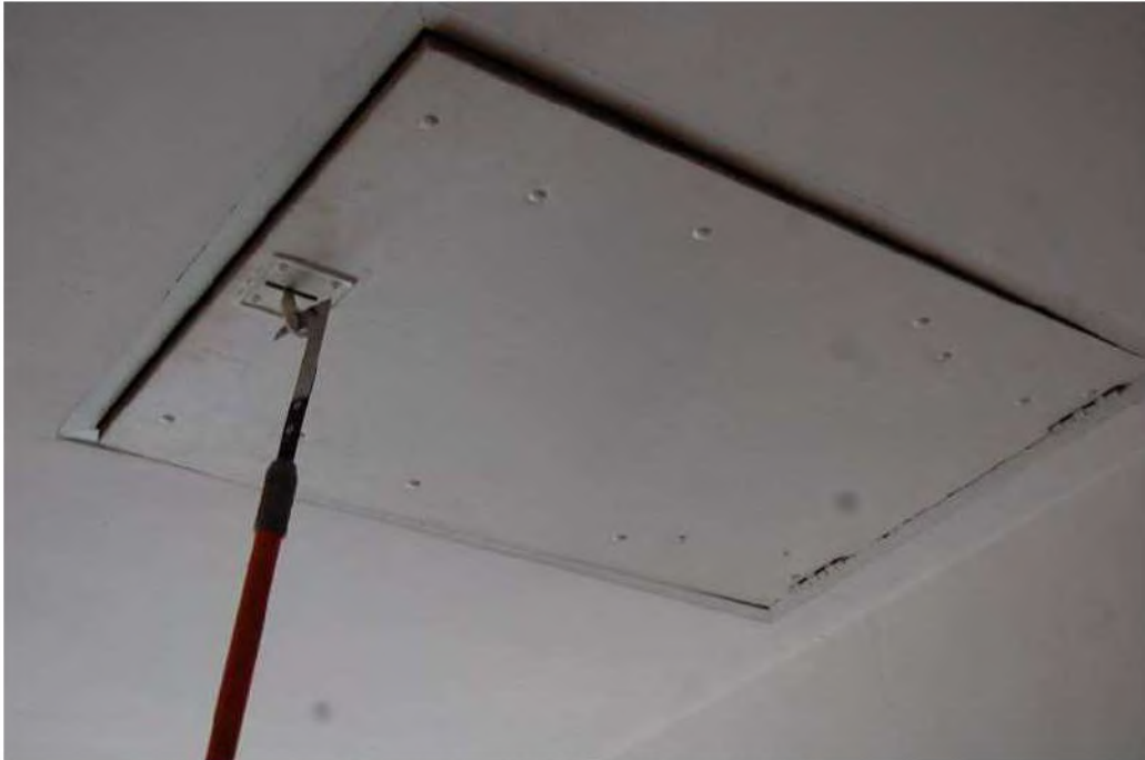
Foto n. 1 – Botola ingresso soffitte
