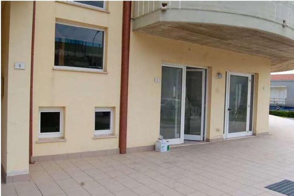
Foto n. 1 – Vista esterna Sub 4
