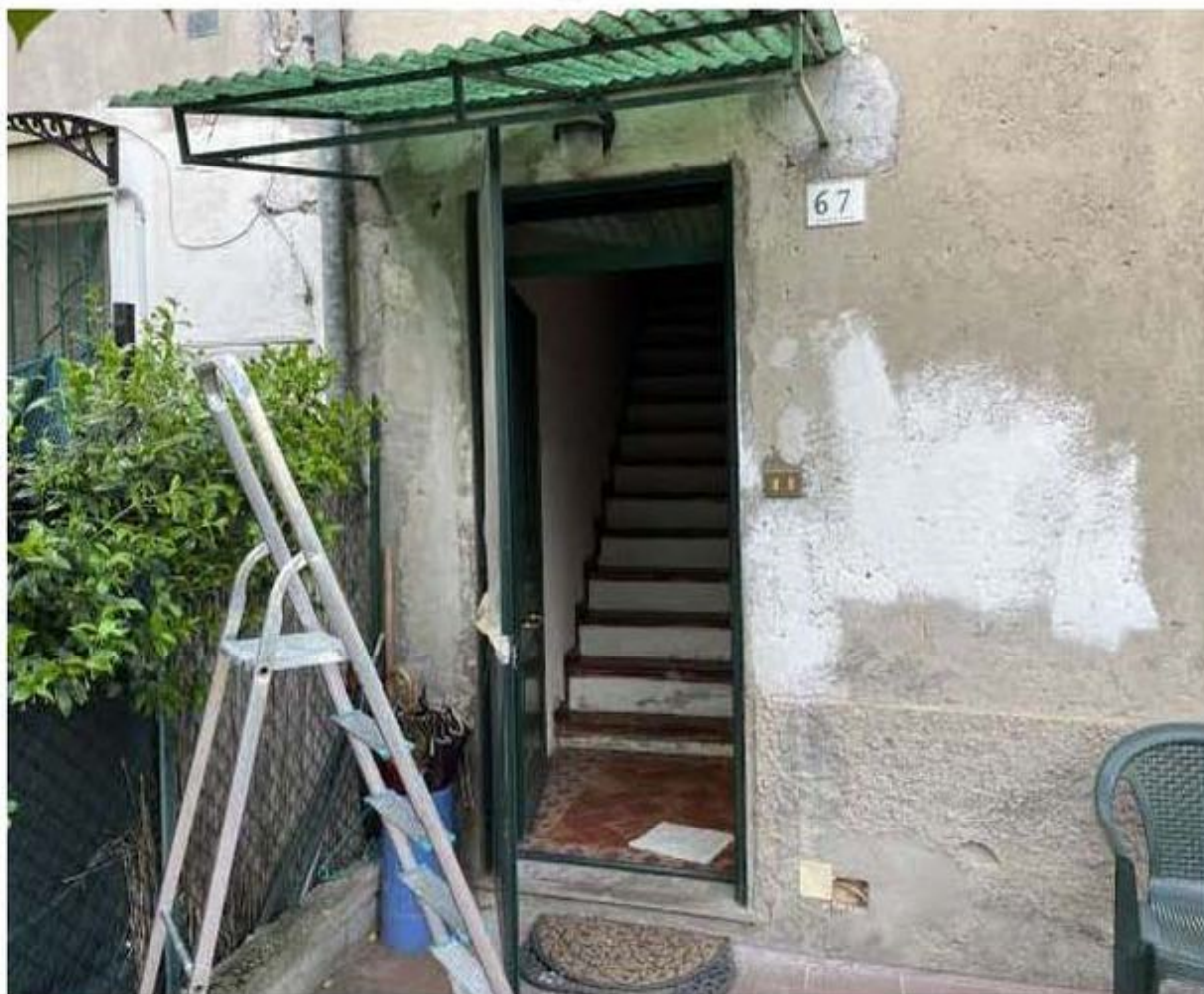
Ingresso del fabbricato oggetto di esecuzione
