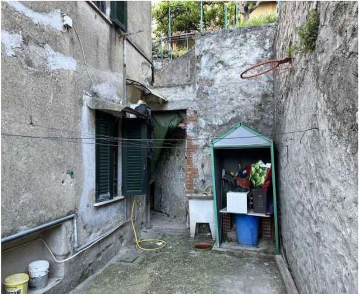
Area urbana comune (F. 73 P.lla 113 Sub 5) e ingresso alla cantina
