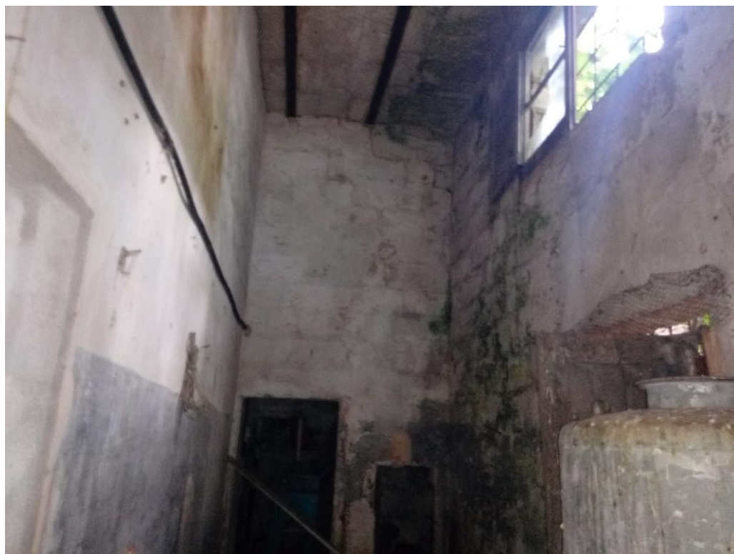
Vani deposito sottostanti (sub. 12)
