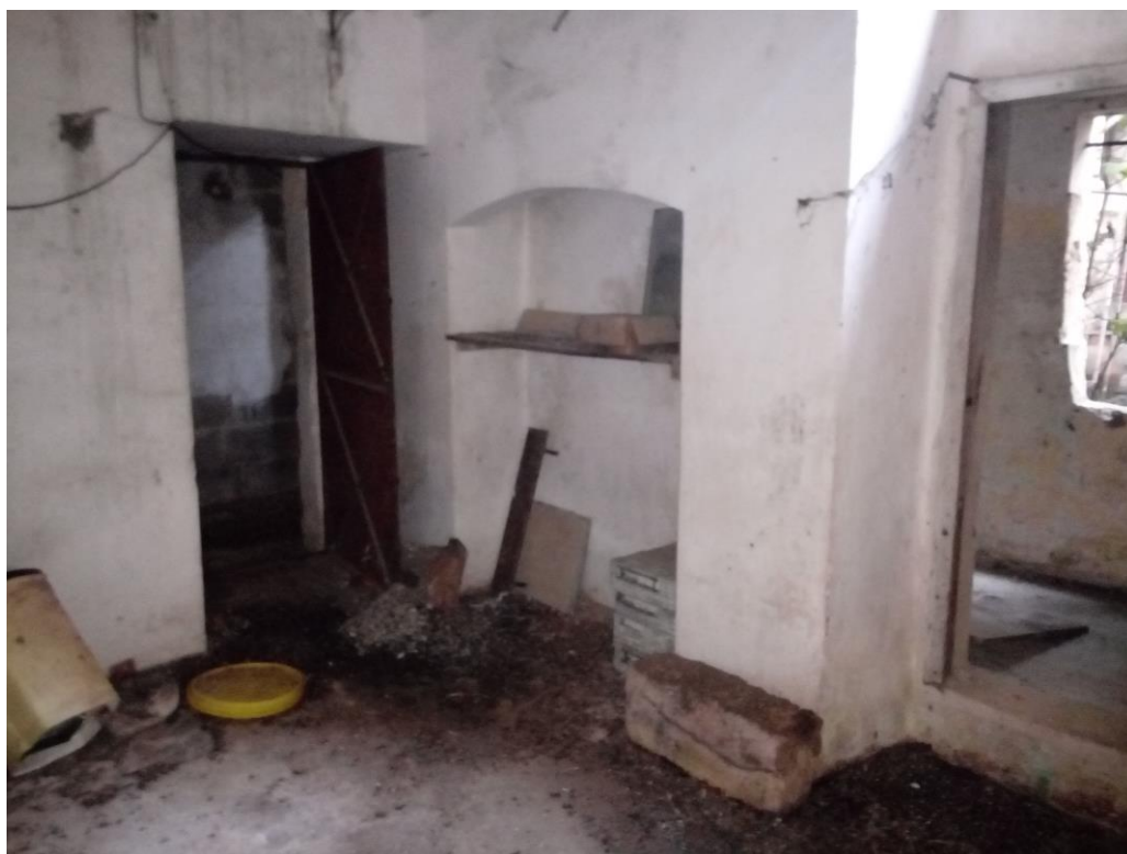
Vani deposito sottostanti (sub. 12)
