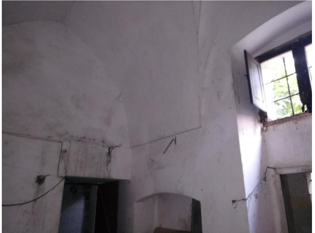
Vani deposito sottostanti (sub. 12)
