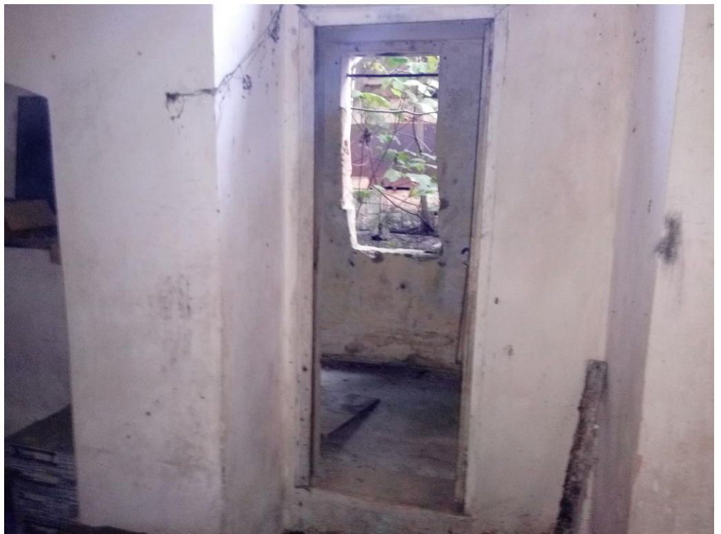
Vani deposito sottostanti (sub. 12)
