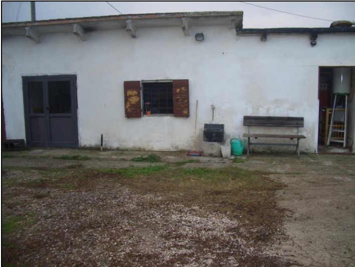
Vista accessorio centrale con porzione a Nord da demolire
