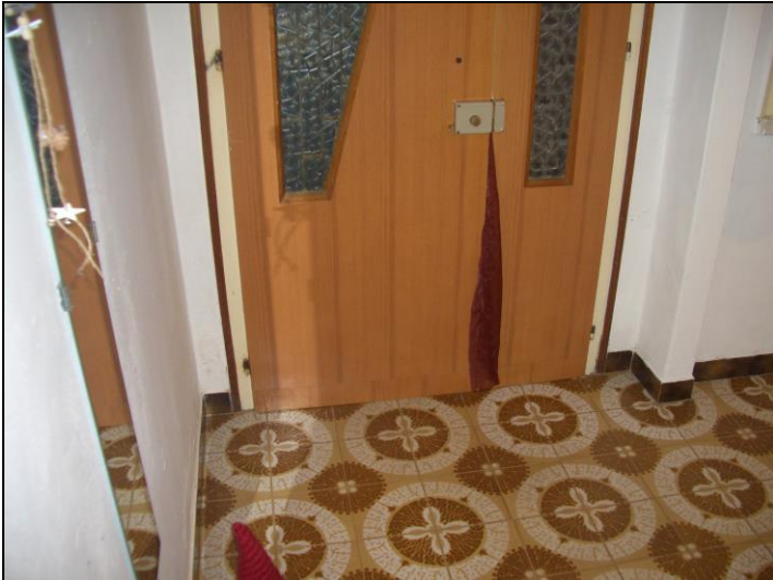
Vista interna P.T. abitazione
