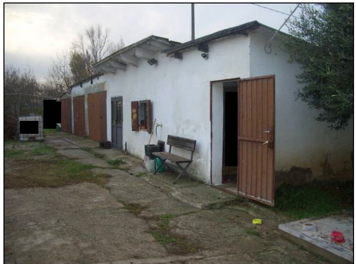
Vista accessorio centrale con porzioni a Nord e Sud da demolire
