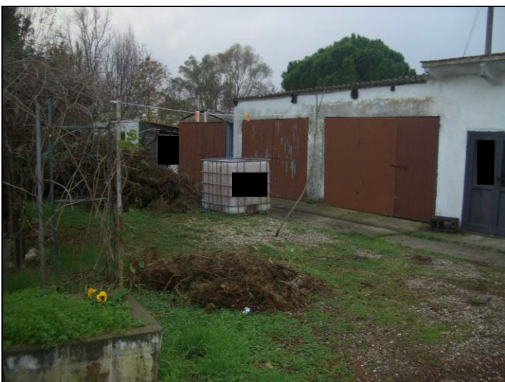
Vista porzione accessori a Sud da demolire
