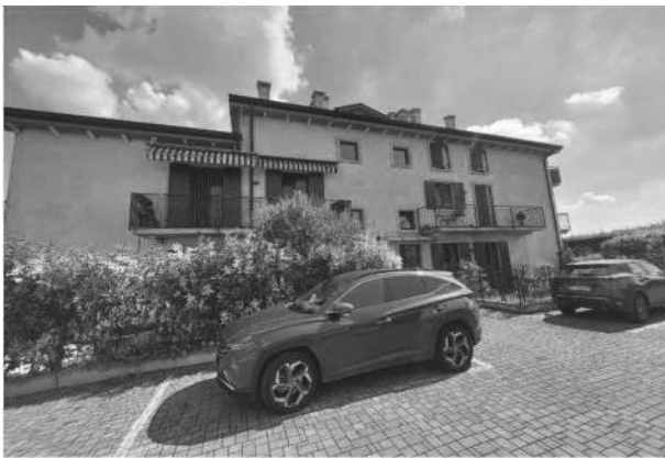
Figura 9: ripresa fotografica del fabbricato effettuata dalla corte comune
