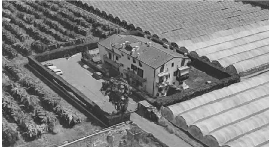
Figura 8: aerofotogrammetria del fabbricato nel quale si sviluppano le unità oggetto di valutazione
