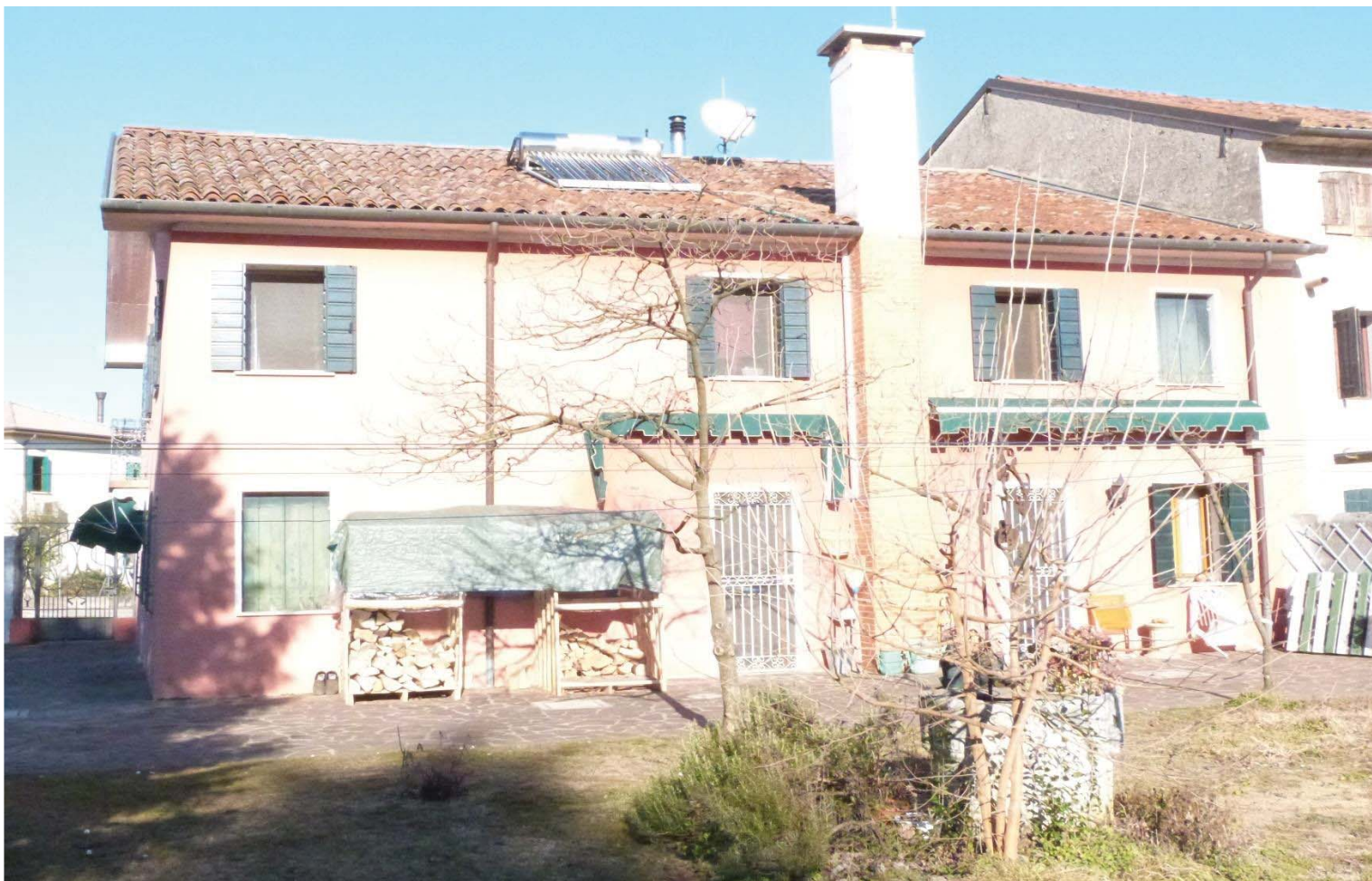
Vista del fronte sud.
