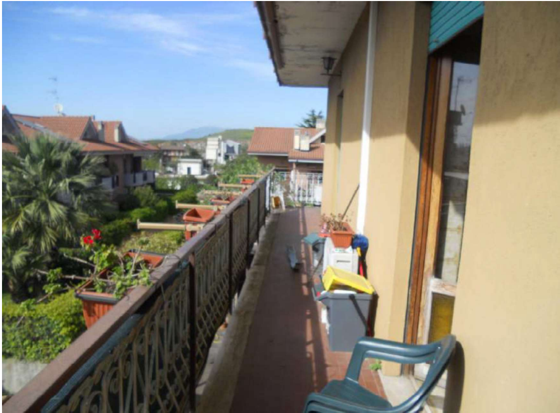
Foto n°11 –Balcone della cucina dell'appartamento al piano primo int.3
