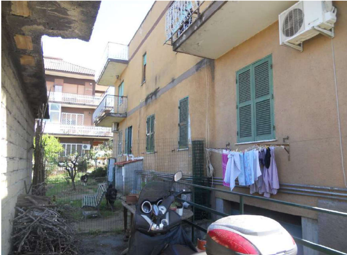
Foto n° 5 – Prospetto nord del fabbricato
