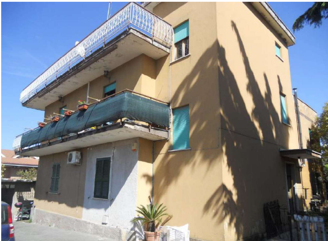
Foto n° 4 – Prospetto ovest del fabbricato
