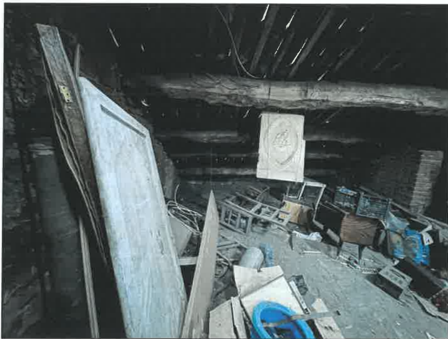
Immagini 45: locale di sgombero nel sottotetto
