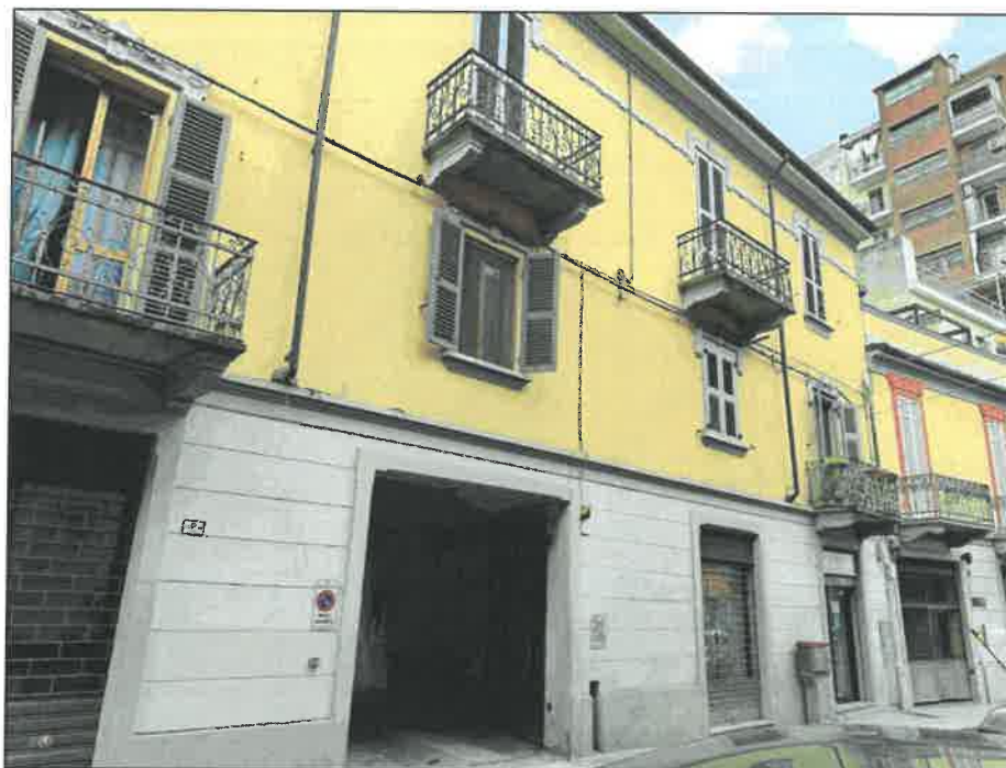
Immagini 5: Prospetto su Via Lumelli
