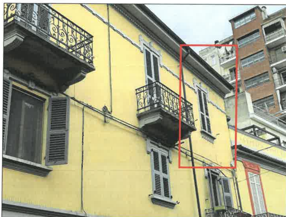
Immagini 6: Prospetto su Via Lumelli
