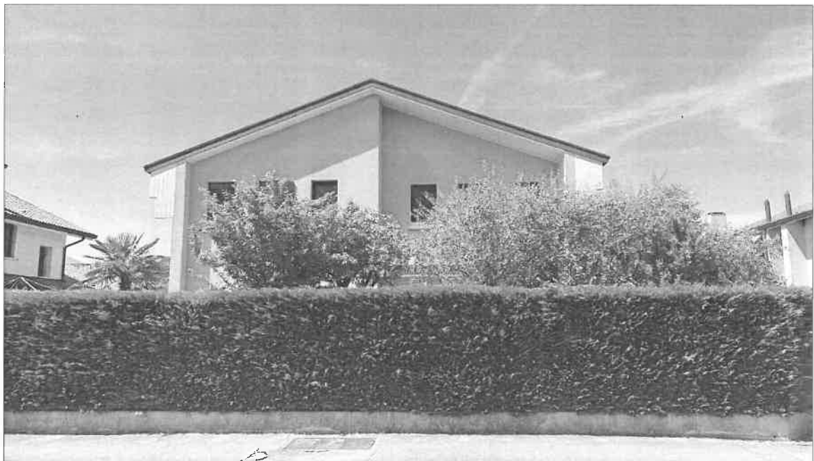
Vista del fabbricato "A" da via Pacinotti, a Est
