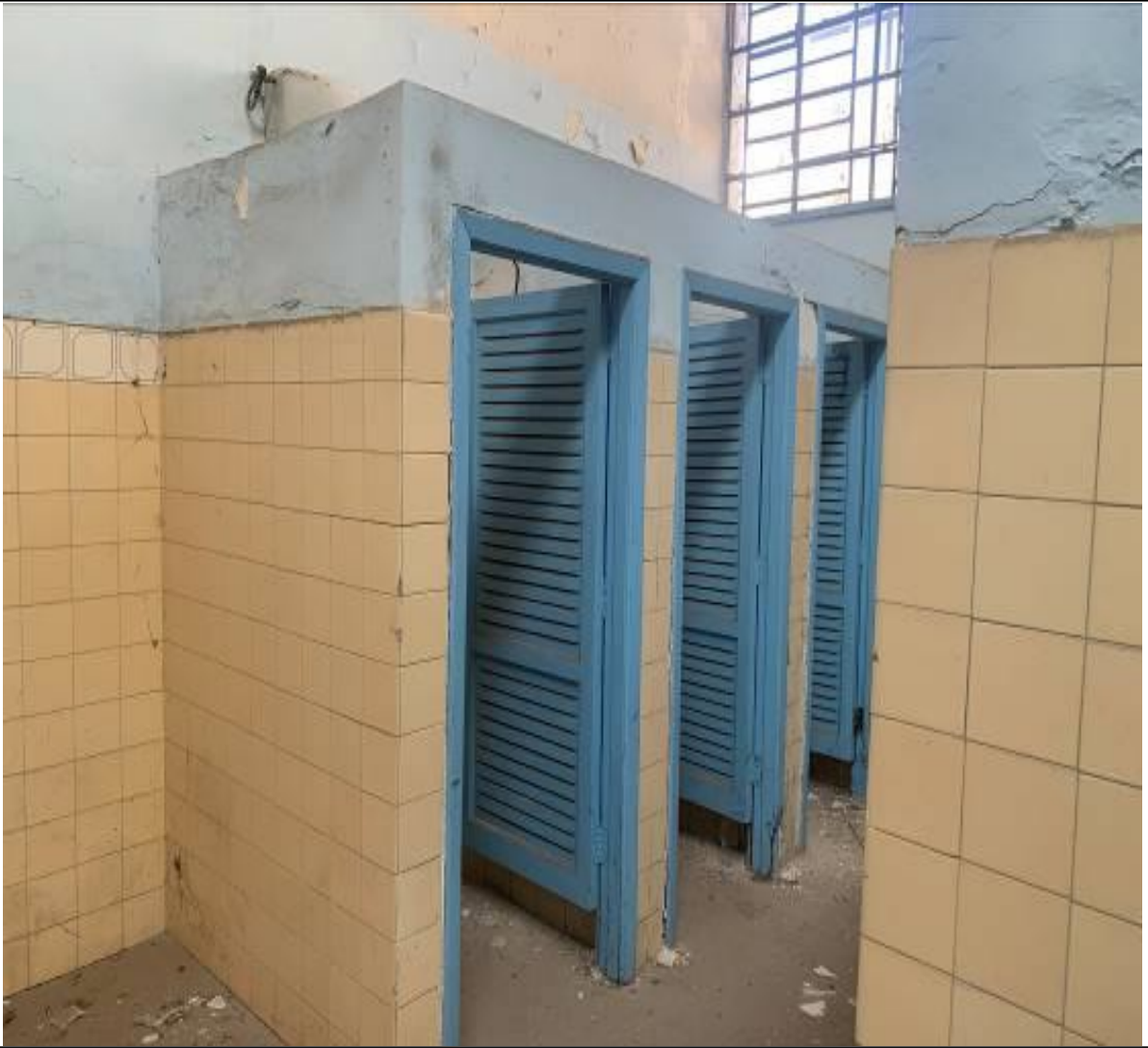
Immagine n. 13– Locali bagno
