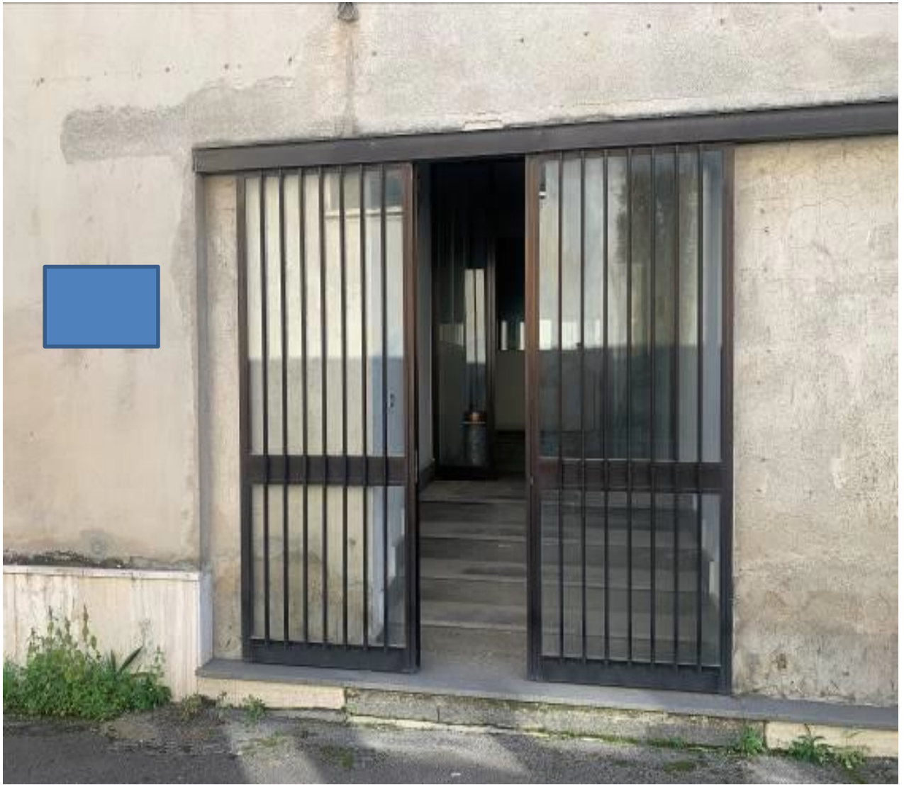
Immagine n. 1 – Ingresso uffici
