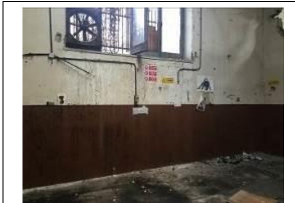
Immagine n. 49 - Dettaglio parete perimetrale
