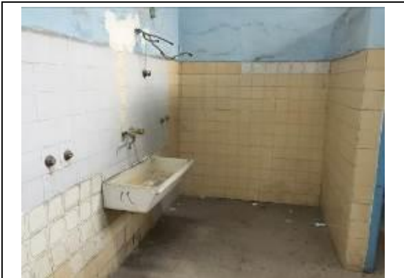
Immagine n. 24 - Locali bagno
