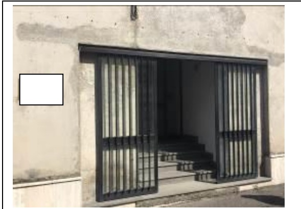
Immagine n. 6 - Ingresso uffici
