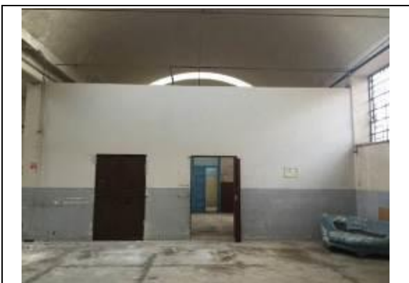
Immagine n. 26 - Vista d'insieme locali bagno
