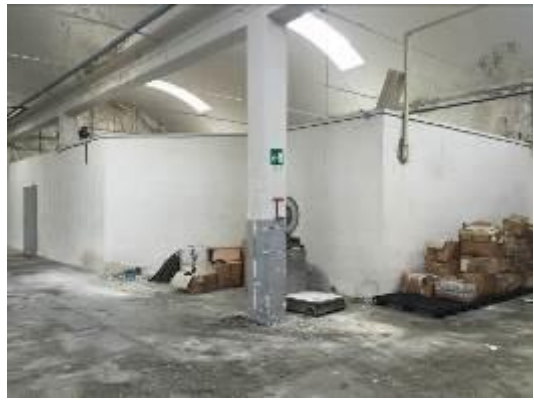
Immagine n. 41 - Vista d'insieme locale uffici
