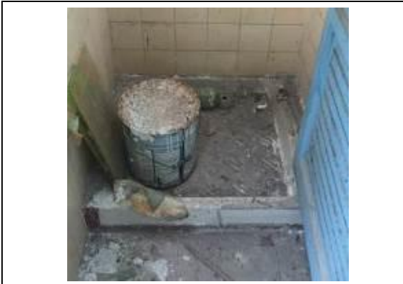
Immagine n. 22 - Locali bagno
