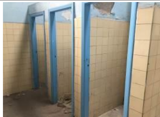
Immagine n. 21 - Locali bagno
