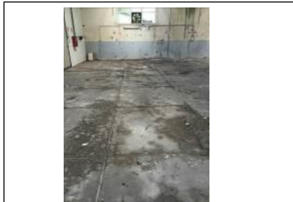
Immagine n. 9 - Pavimentazione
