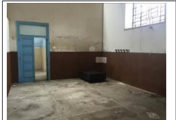
Immagine n. 25 - Locale antibagno
