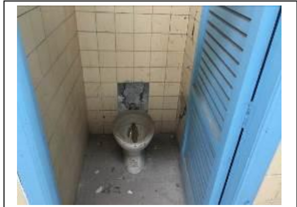
Immagine n. 23 - Dettaglio w.c.
