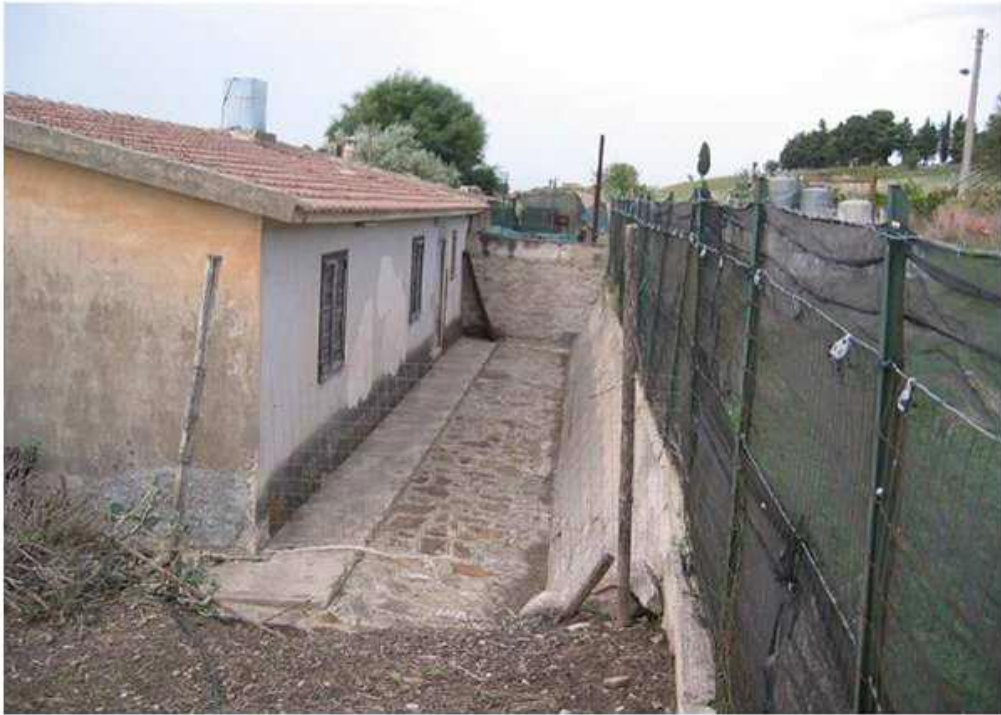
VEDUTA SCARPATA LATO EST
