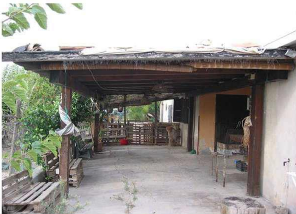
VISTA IN DIREZIONE INGRESSO LOTTO
