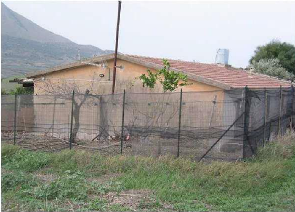
VEDUTA D'INSIEME LATO SUD
