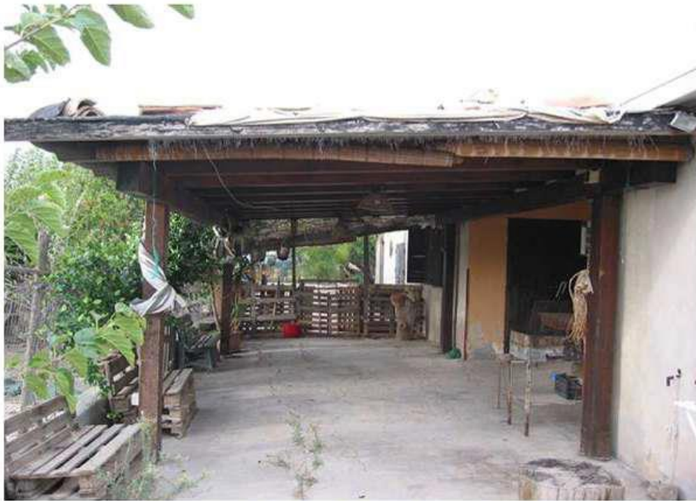
VISTA IN DIREZIONE INGRESSO LOTTO
