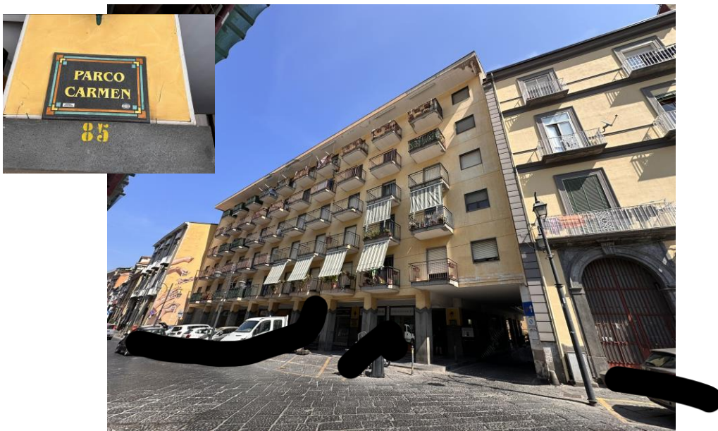
Prospetto principale dalla Via Roma
