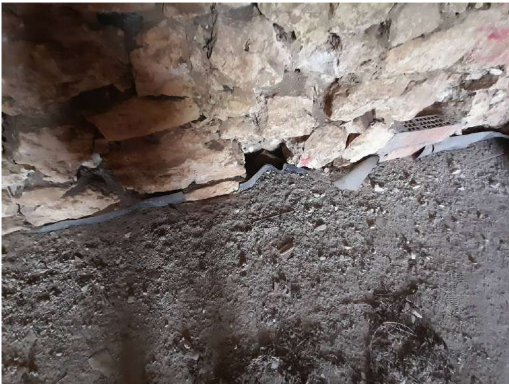
Interni Edificio A
