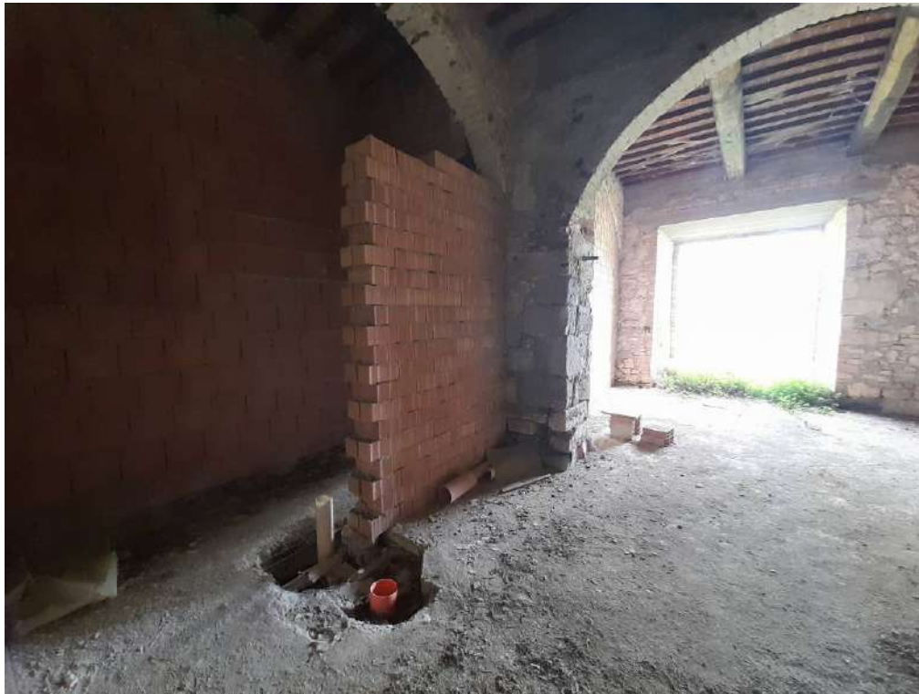
Interni Edificio A
