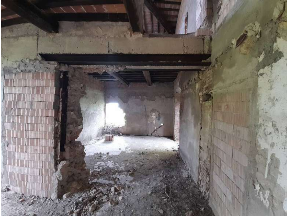
Interni edificio C
