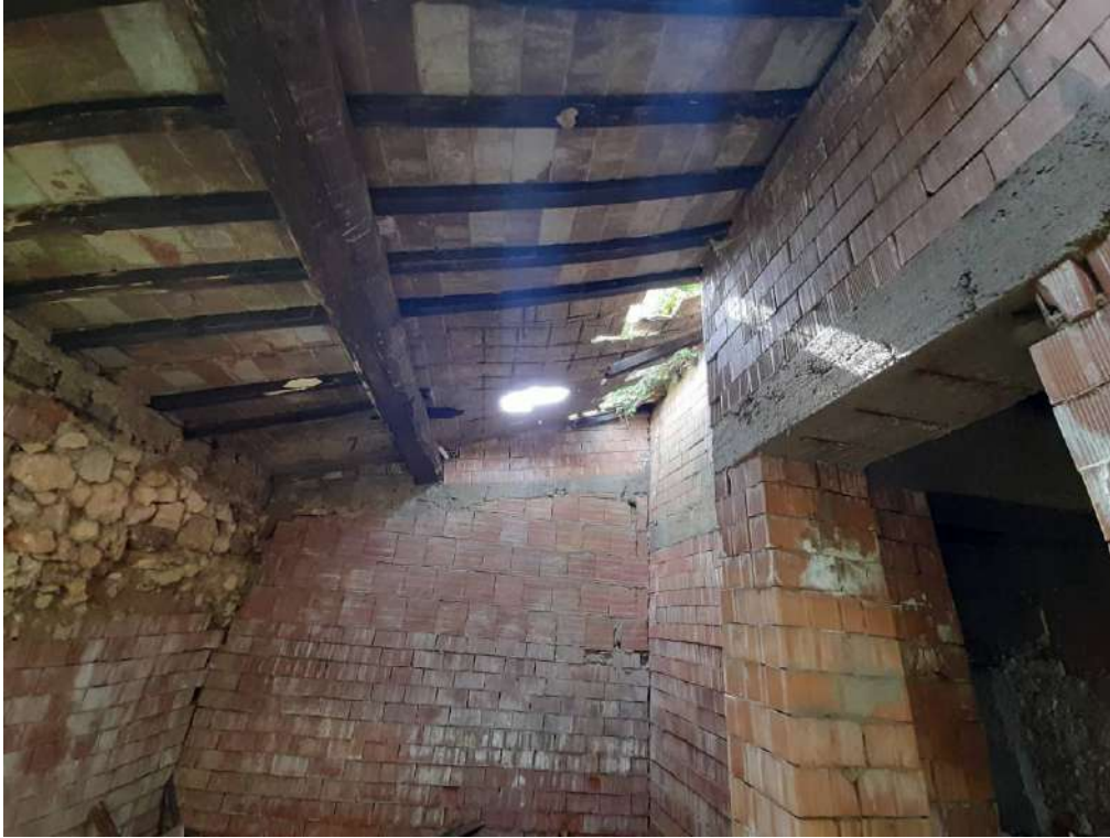
Interni edificio C
