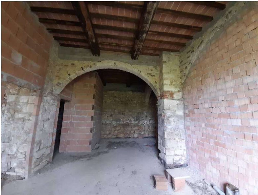
Interni Edificio A
