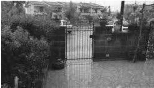
Corte esterna - ingresso pedonale.
