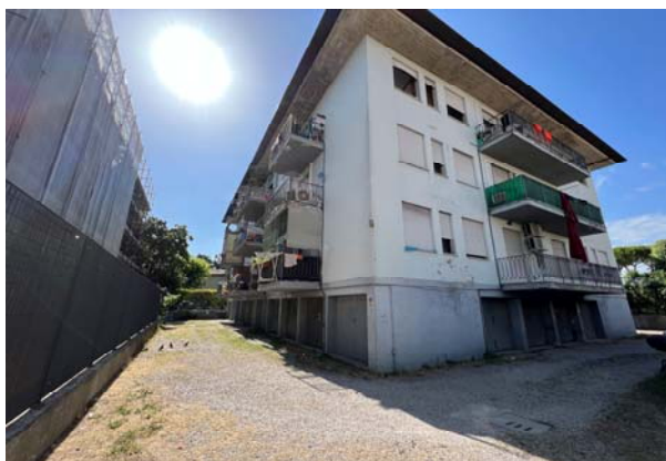
Ripresa prospetto sud ovest
