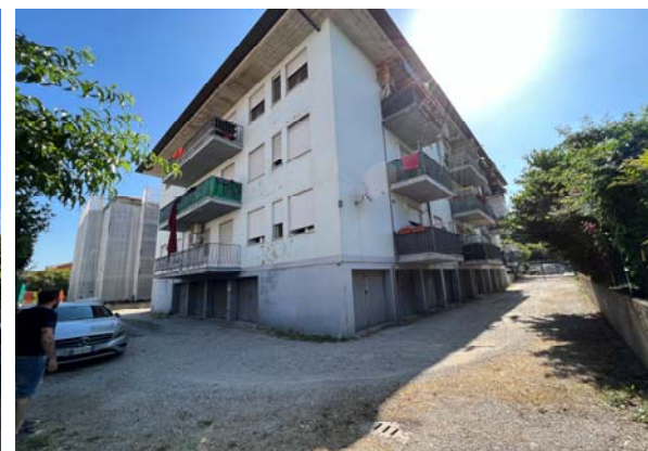
Ripresa prospetto sud ovest
