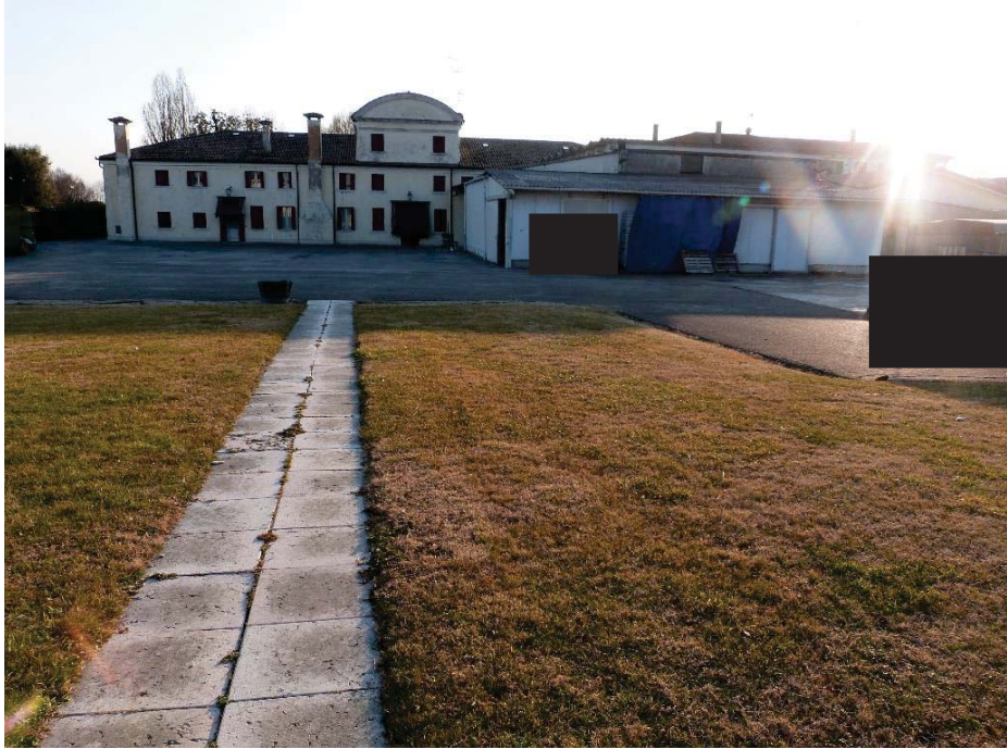
5 Fronte nord della villa con il volume produttivo aggiunto e parte dell'area scoperta a nord.
