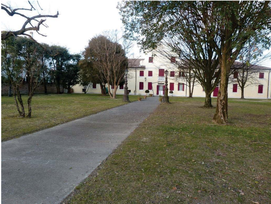
1 Fronte sud della villa con l'area scoperta antistante.
