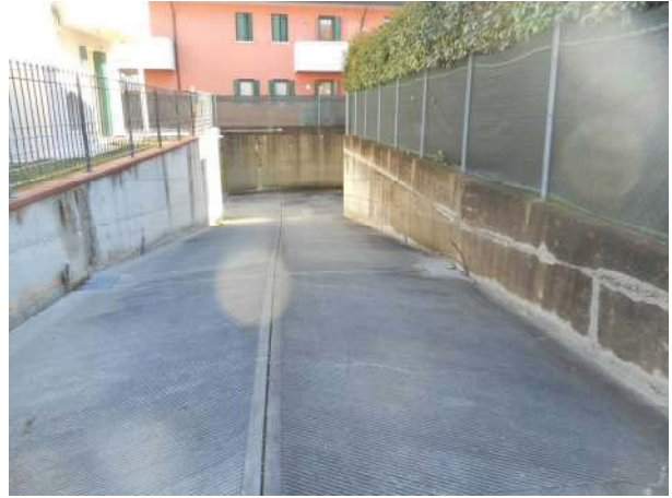
Foto 2 – rampa di accesso al piano sottostrada
