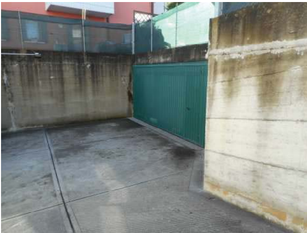
Foto 3 – ingresso area di manovra
