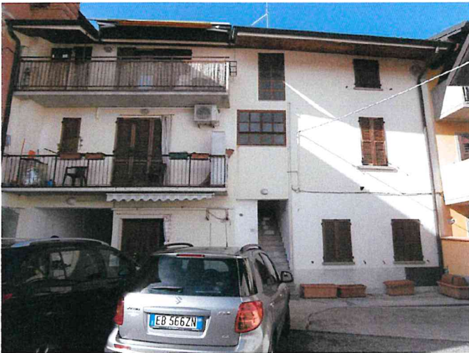
Foto 02 - Fabbricato cui appartengono i beni - prospetto Sud-Est
