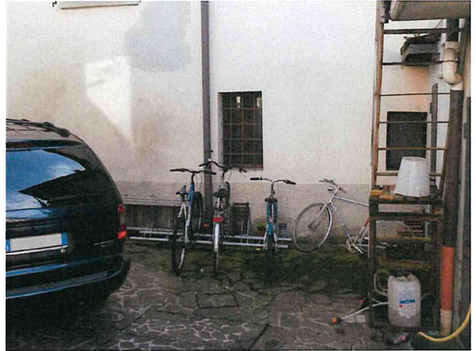
Foto 08 - prospetto Nord alloggio
