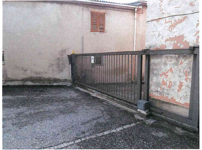
Foto 01 - Cancellone pedonale e carrale di accesso
