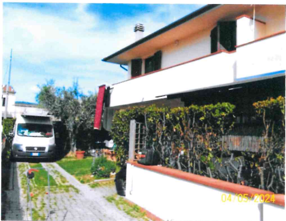
FOTO 2: VISTA PROSPETTO OVEST
