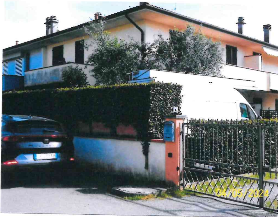
FOTO 3 : VISTA PROSPETTI NORD-OVEST
