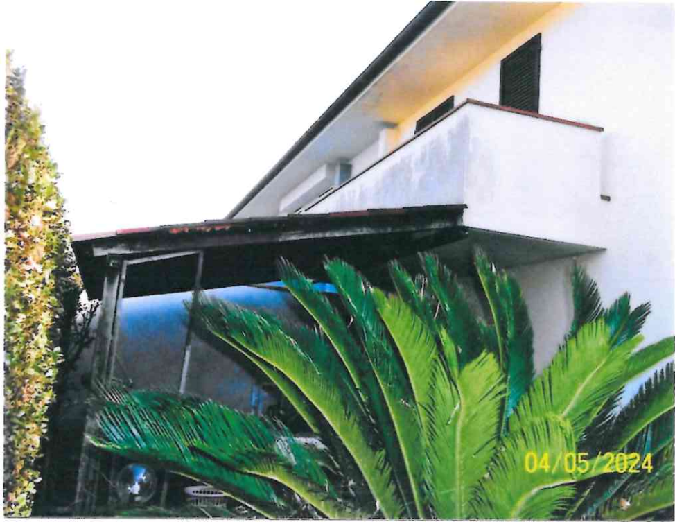
FOTO 5: PARTICOLARE PROSPETTO NORD
