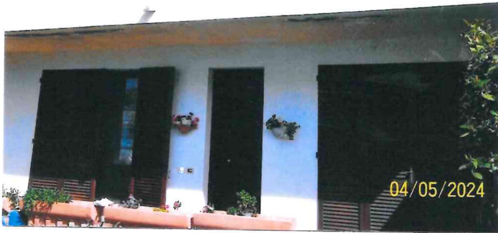
FOTO 7 : VISTA PROSPETTO OVEST
