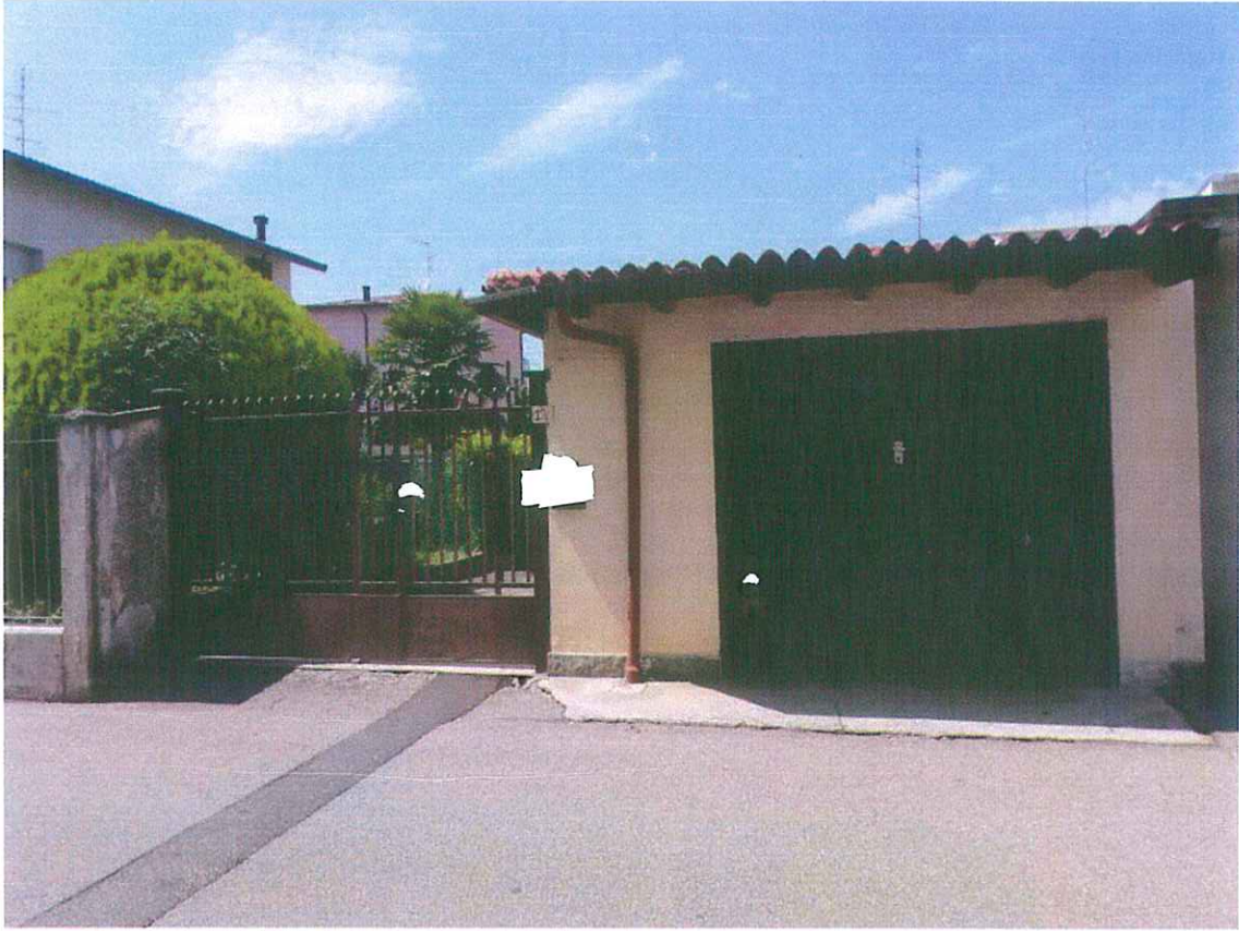
Accesso da via Ariosto
