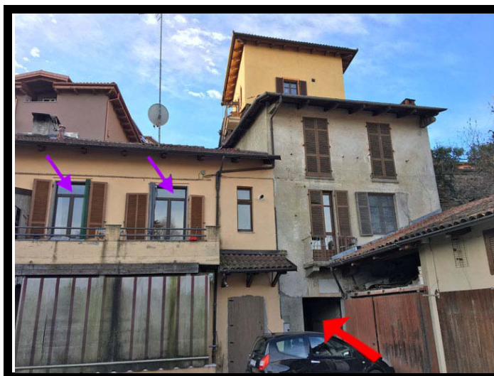
Fotografia di una porzione del fronte lato cortile (posto sul lato della Via PARTIGIANI D'ITALIA).
