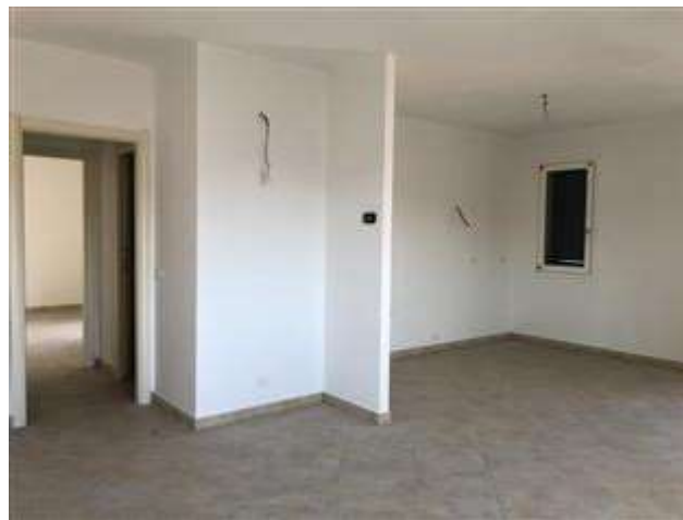
Foto della spillina in muratura
