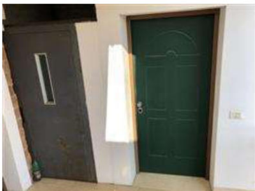
Particolare del portoncino di ingresso
