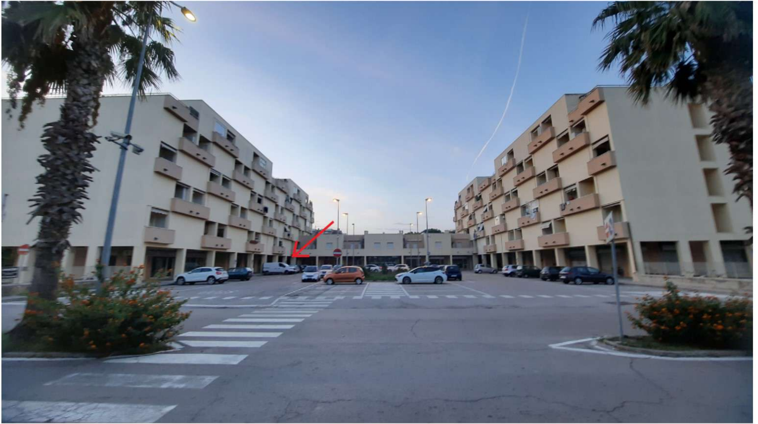
Foto 1 - Prospetti sud e est fabbricato (vista da via Faleria)
