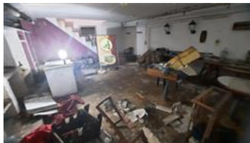
Fondaco/magazzino al piano sottostrada
