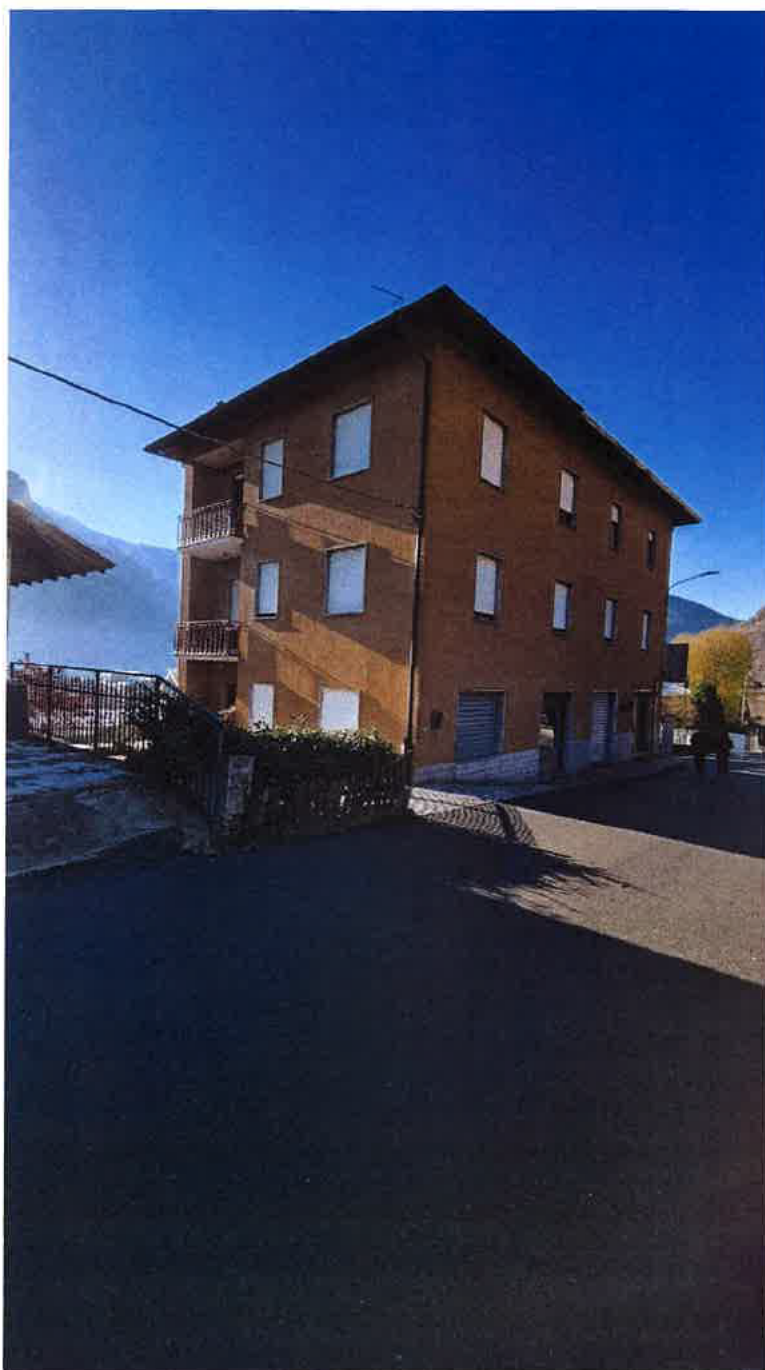
FOTO 1 – VISTA ESTERNA IMMOBILE MAPP 254
