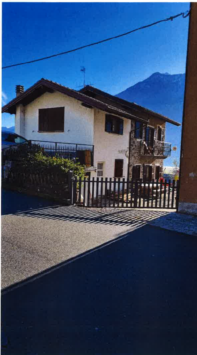
FOTO 7 - VISTA ESTERNA IMMOBILE MAPP 361
