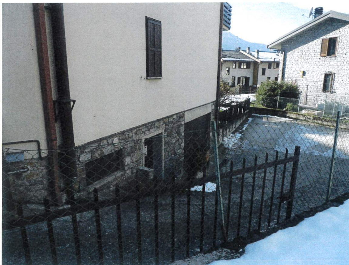
Comune di Tresivio - Lotti Due, Tre e Sei -
