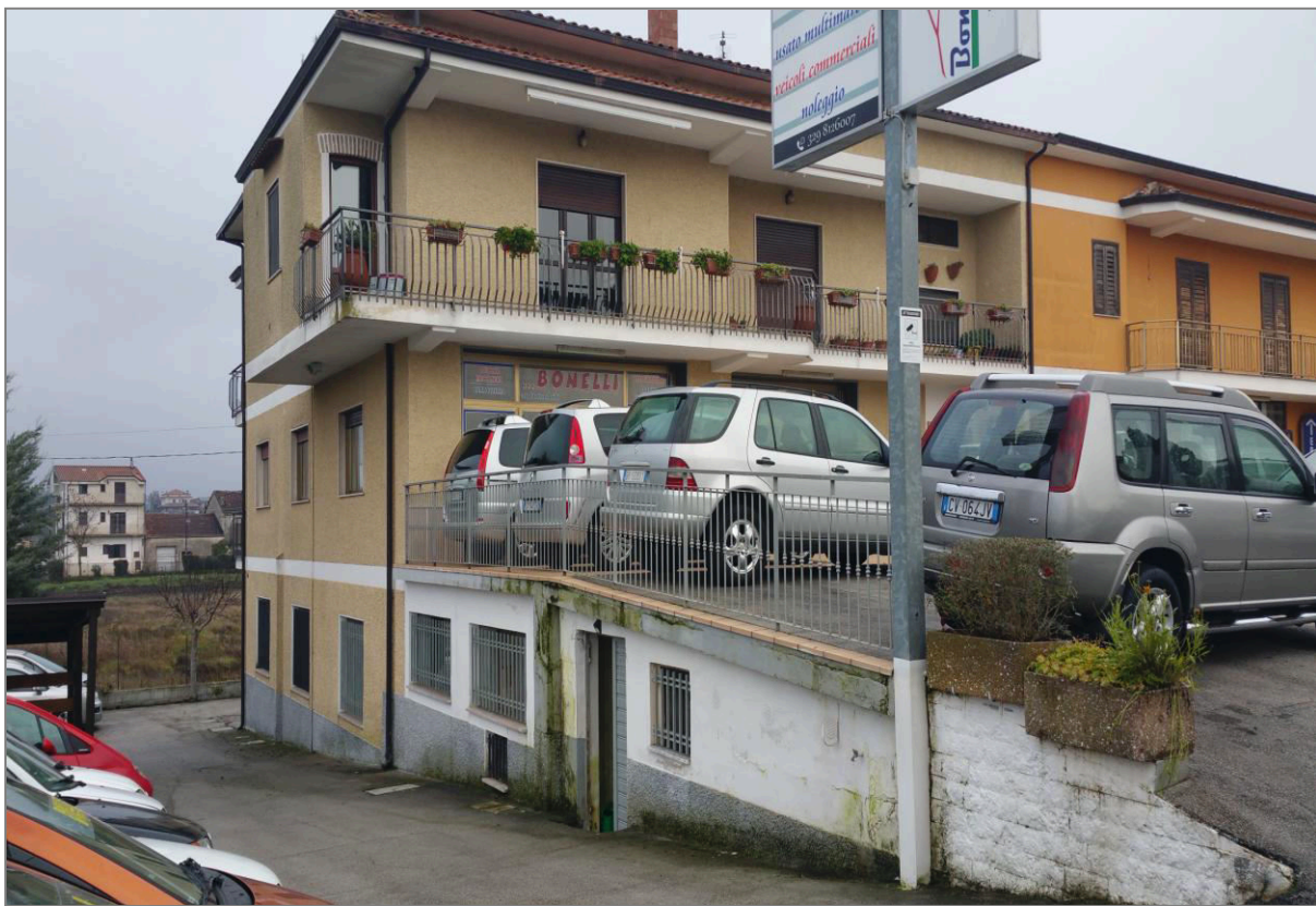
Veduta immobile delle facciate principale e laterale lato Ovest e Nord dalla S.S. N. 19 ↑
