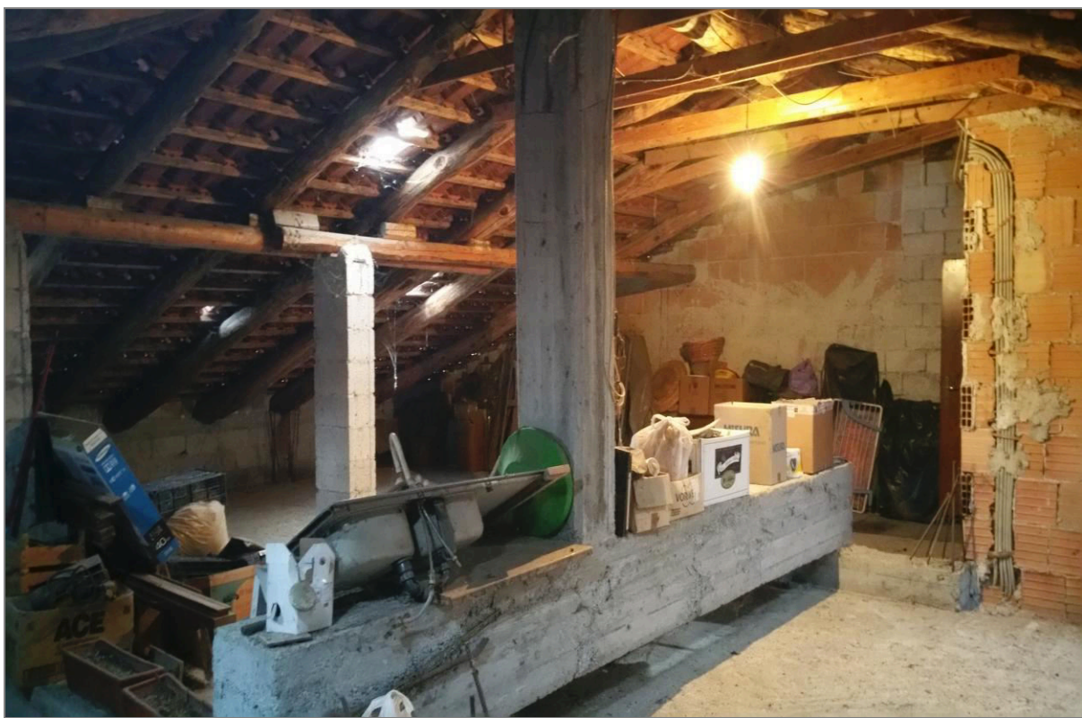
↑ Veduta interna di insieme del P. Sottotetto
