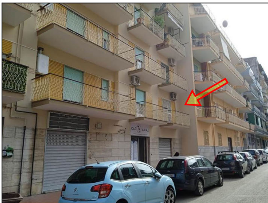
Vista esterno edificio da via Filippo Turati
