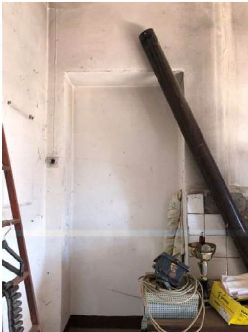
PORTA RICHIUSA CHE COLLEGA LA CUCINA AL RESTO DELL'ABITAZIONE ATTUALMENTE INTERCLUSA
