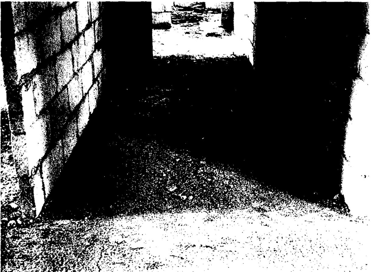
Foto n. 6: Primo edificio al centro del terreno – corridoio centrale dell'abitazione al primo piano, guardando verso il WC opposto all'ingresso. Si notano: le "tufelle" divisorie e la "caldana" del solaio inferiore a pavimento.
