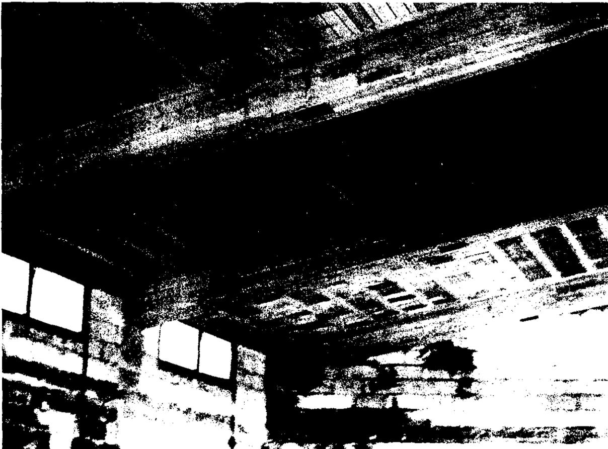
Foto n. 10: Secondo edificio, ubicato verso la parte terminale del terreno dalla parte opposta rispetto all'ingresso, destinato a magazzino. Si notano: l'intelaiatura e le travi inclinate di copertura in c.a., il solaio inclinato laterocementizio, la tompagnatura perimetrale in muratura di tufo, le finestre alte nella parte posteriore.
