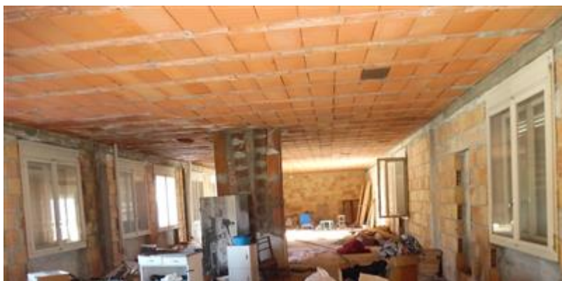
Soffitta con balcone p.2
