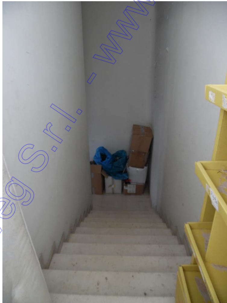
Vano scale comune p.T-1 (sub. 5)
