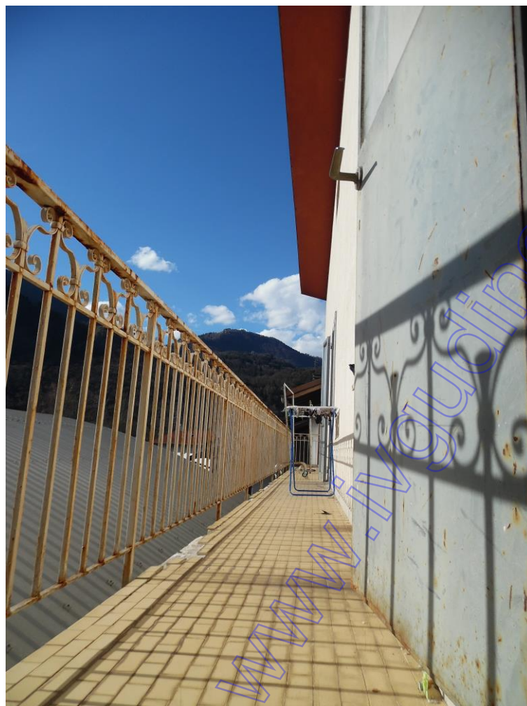
Balcone comune p.2 (sub. 5)
