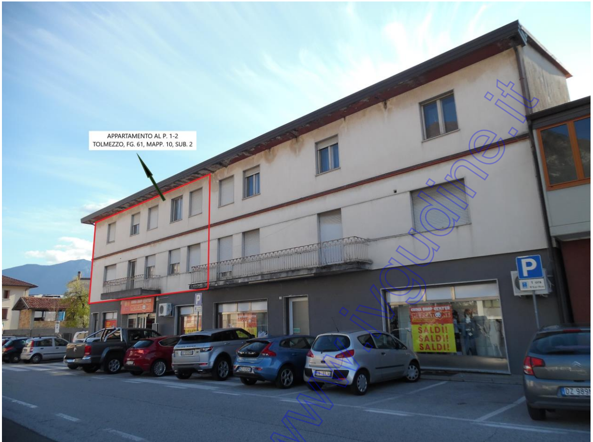
Prospetto N/E da fronte strada Via Paluzza
