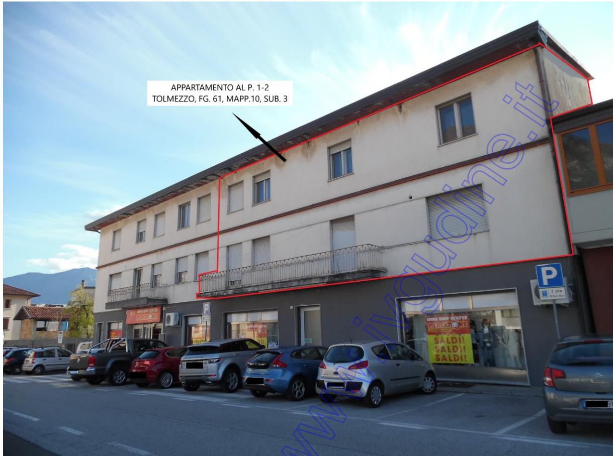
Prospetto N/E da fronte strada Via Paluzza
