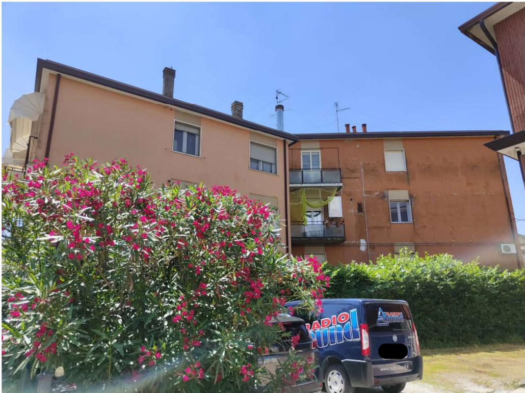
FOTO 2 – Vista fronte laterale
