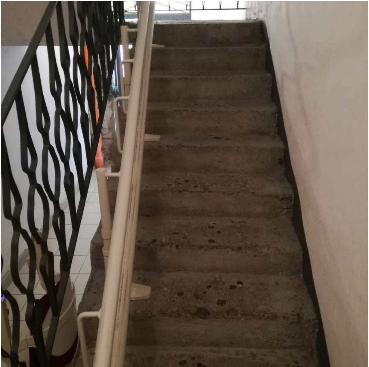
Foto n. 8 - Vista della scala interna comune di accesso alle unità immobiliari del fabbricato in cui è posto l'immobile pignorato
