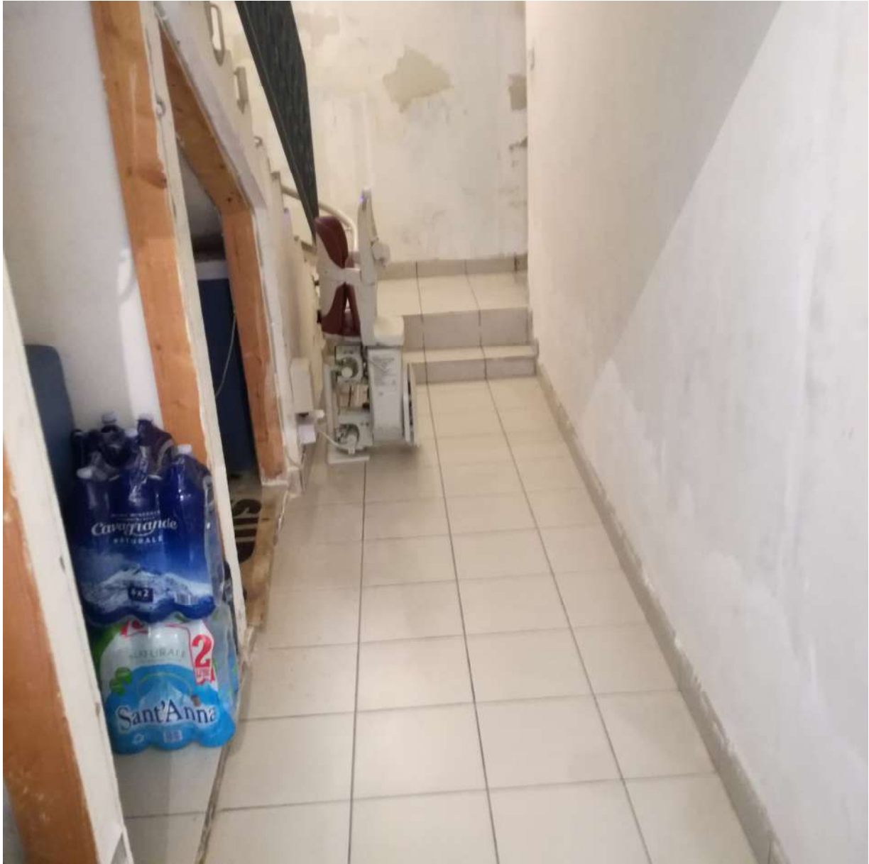
Foto n. 7 - Vista dell'ingresso comune dalla via Padova n. 41 del fabbricato in cui è posto l'immobile pignorato
