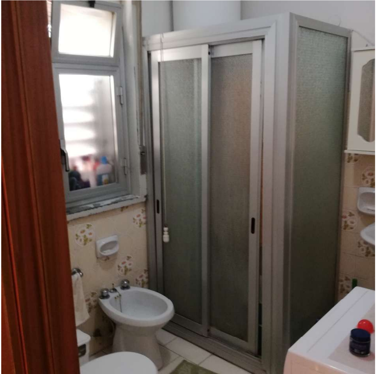
Foto n. 15 - Vista del bagno dell'immobile pignorato
