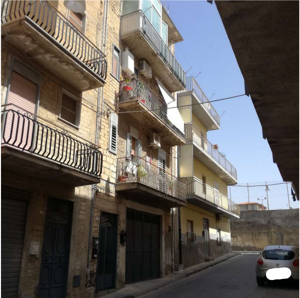
Foto n. 1 - Vista esterna dalla via Padova del fabbricato in cui è posto l'immobile pignorato
