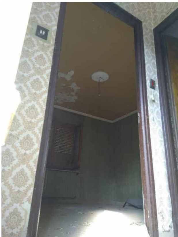
FOTO 71 (locale nord-ovest al piano primo)
