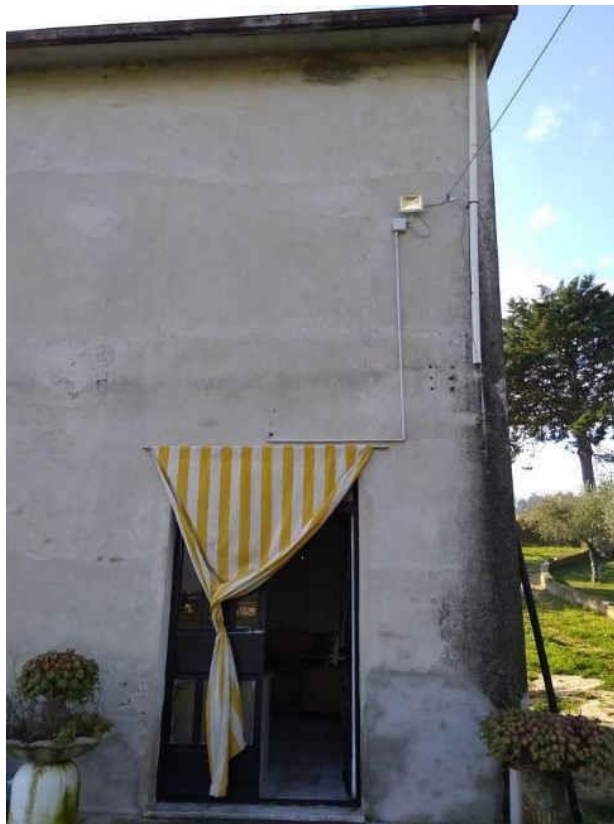
FOTO 68 (ingresso magazzino ovest al piano terra)
