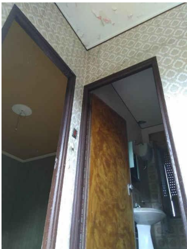
FOTO 72 (locale nord-ovest / disimpegno / bagno al piano primo)
