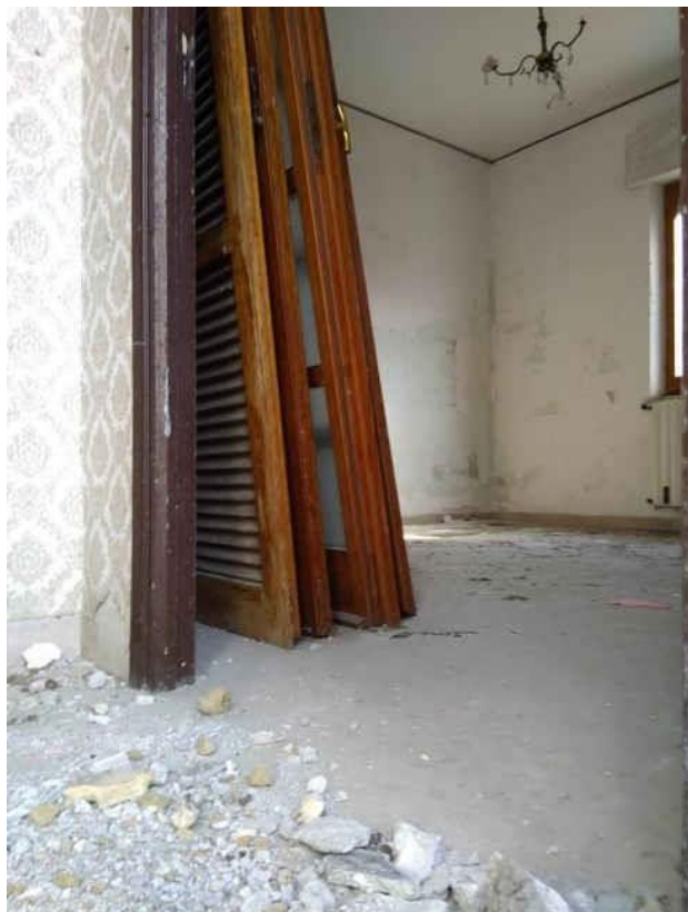
FOTO 73 (locale nord-est al piano primo)
