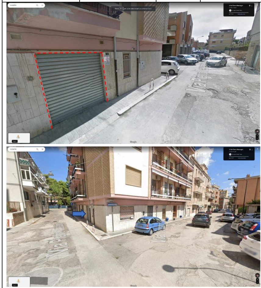
Deposito in Lucera (FG) via Pietro Mascagni n. 8 – Piano Terra
