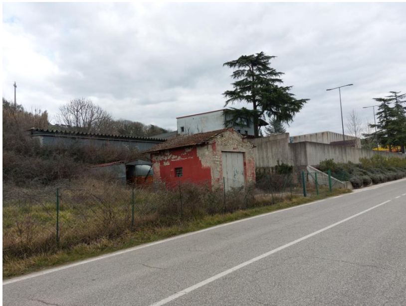
Foto n.80: Particolare del fabbricato industriale, cui appartiene la porzione pignorata identificata in perizia come BENE M (laboratorio, uffici e servizi), ripreso dalla strada Tiberina 3bis. Nella foto è visibile il muro perimetrale in cemento armato sul prospetto ovest.
