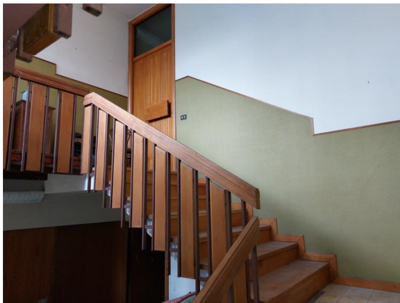
Foto n.72: Altro particolare della scala di collegamento (BENE L). Notare, al centro dell'immagine, l'ingresso che immette alla soggiorno al piano primo e le pareti in parte intonacate e tinteggiate e parte rivestite con carta da parati.
