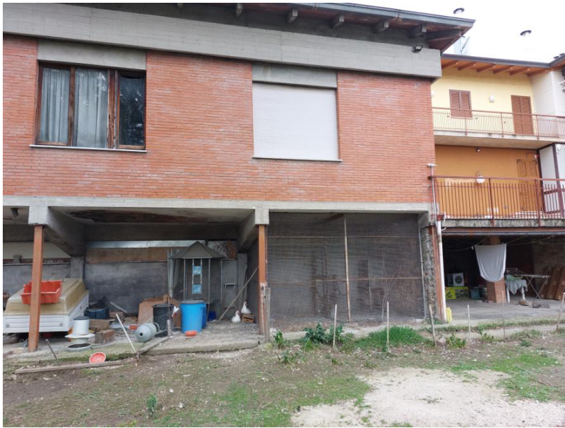
Foto n.65: Altro particolare del fabbricato residenziale (BENI K-L). Sono visibili, al centro dell'immagine, le tamponature esterne intonacate e non tinteggiate al piano terra e con mattoncini stilati a faccia vista al piano primo (BENE L) e sulla destra dell'immagine, le tamponature intonacate e tinteggiate (BENE K). Notare il portico al piano terra e il pavimento in battuto di cemento.
