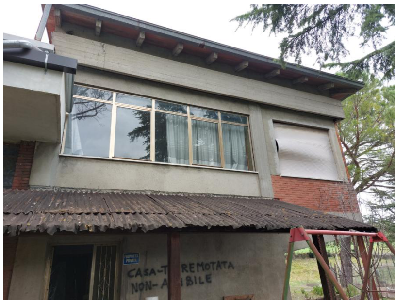
Foto n.68: Altro particolare del fabbricato residenziale (BENE L). Notare gli infissi esterni in alluminio e le finestre con avvolgibile esterno in PVC.
