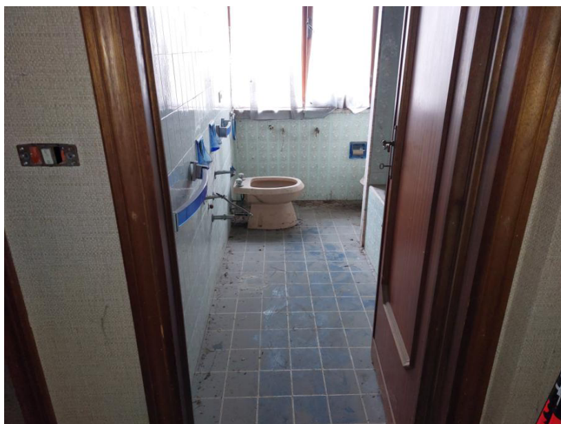
Foto n77: Particolare del bagno al piano primo (BENE L). Notare, sulla destra dell'immagine, la vasca da bagno.
