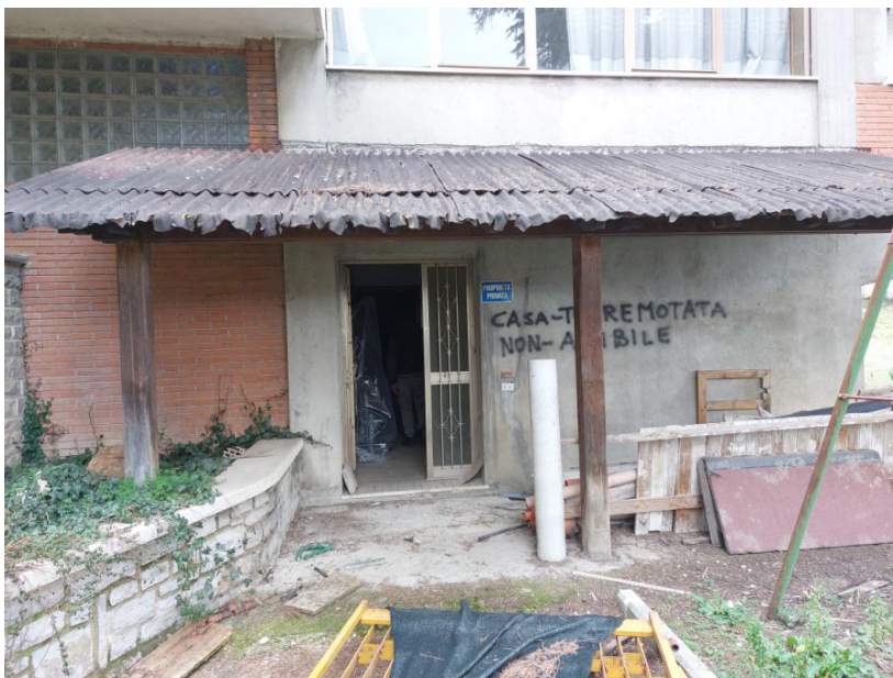
Foto n.67: Particolare del fabbricato residenziale (BENE L) sul prospetto sud-ovest. Notare il portone a due ante in alluminio anodizzato e vetro smerigliato sotto il portico.
