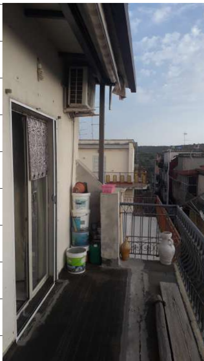
Foto n.35: immagine esterna della veranda ubicata al piano terzo.
