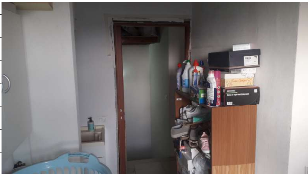
Foto n.34: immagine interna del bagno ubicato al piano terzo.
