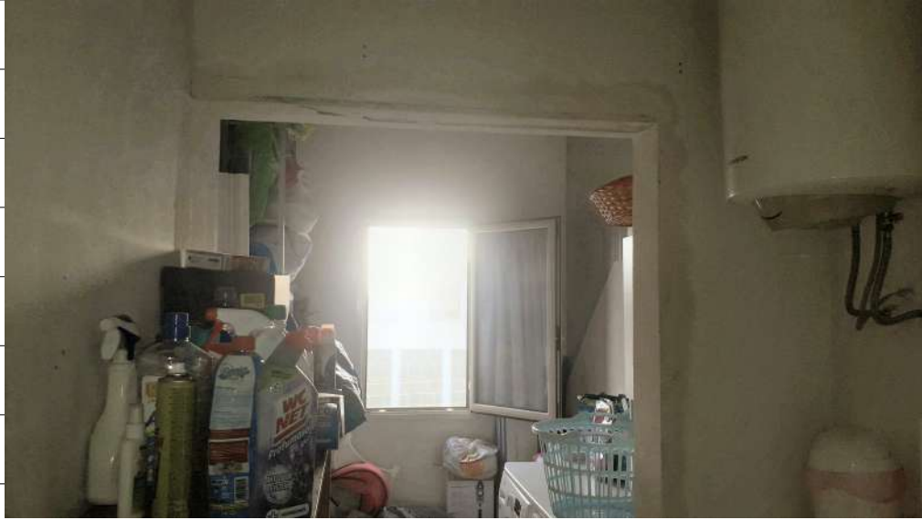
Foto n.33: immagine interna del bagno ubicato al piano terzo.
