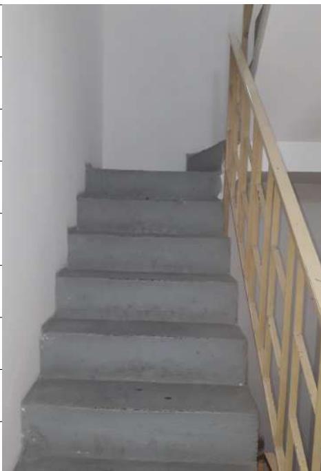
Foto n.19: immagine interna del vano scala di collegamento tra i piani primo e secondo.
