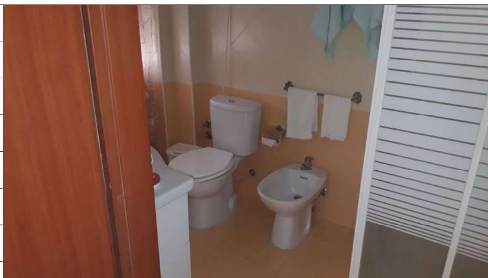
Foto n.15: immagine interna del bagno ubicato al piano primo.
