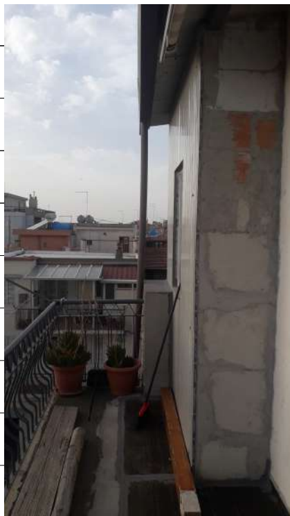
Foto n.36: immagine esterna della veranda ubicata al piano terzo.
