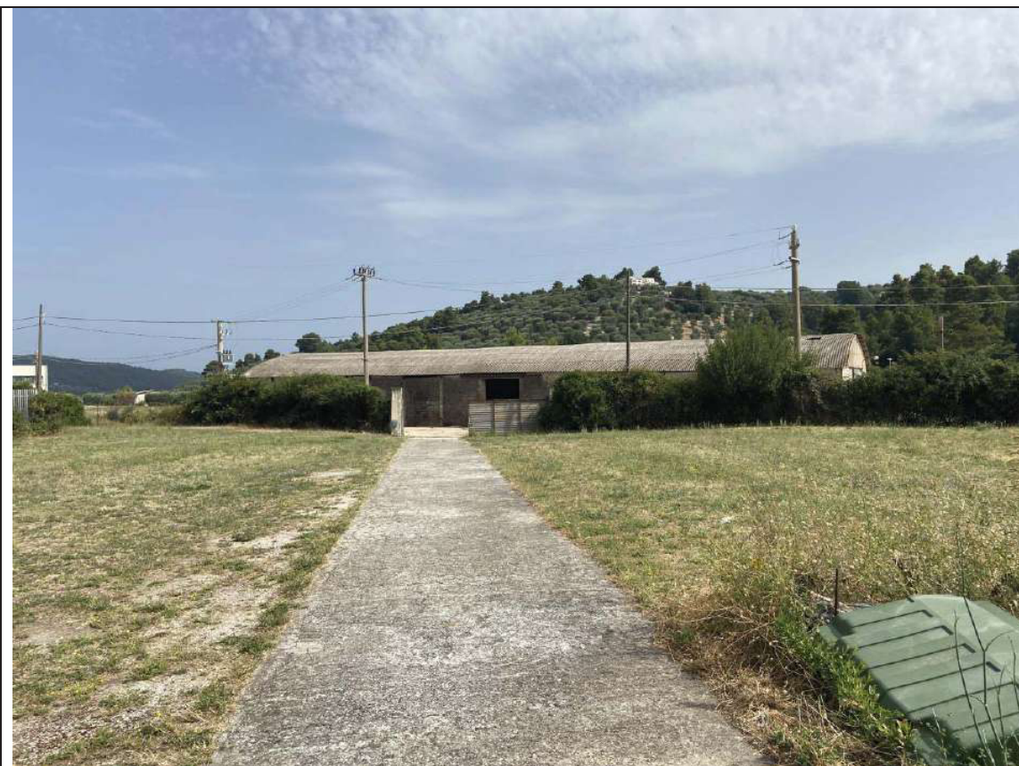
Foto 6) – Vista percorso in cemento di collegamento con IMMOBILE A attraverso IMMOBILE B
