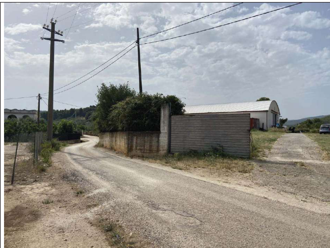
Foto 2) – Vista strada e ingresso IMMOBILE A e B
