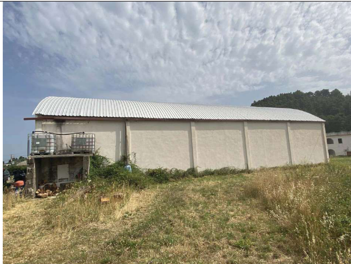
Foto 4) – Vista su prospetto laterale IMMOBILE A
