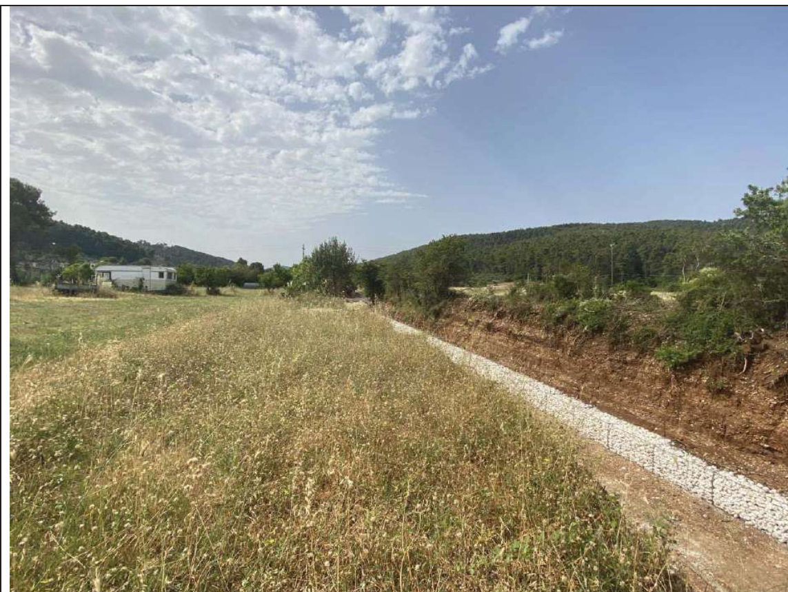
Foto 12) – Vista terreno p.lla 72 ( IMMOBILE B ) lungo confine con Fosso del Lampia
