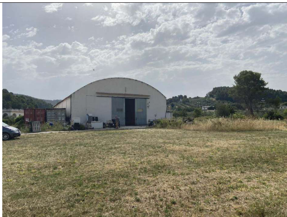
Foto 3) – Vista su prospetto principale IMMOBILE A
