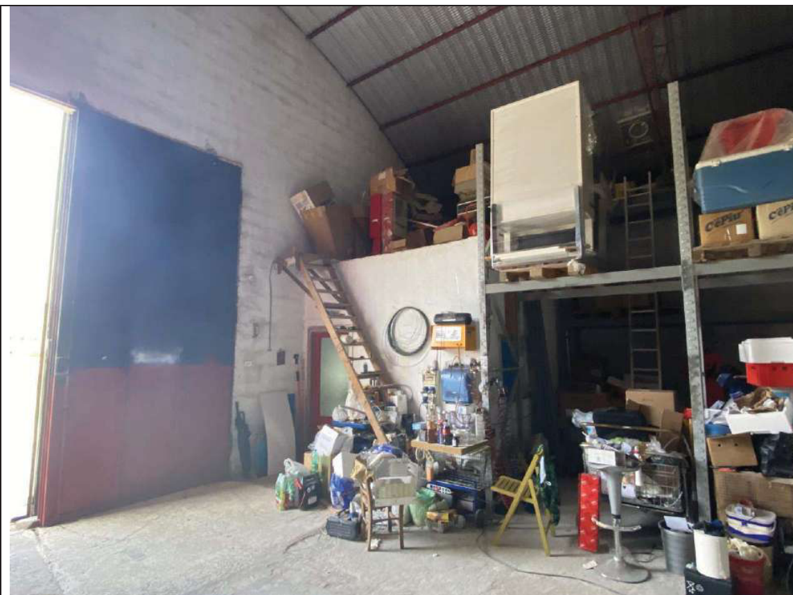
Foto 8) – Vista interna IMMOBILE A verso ufficio
