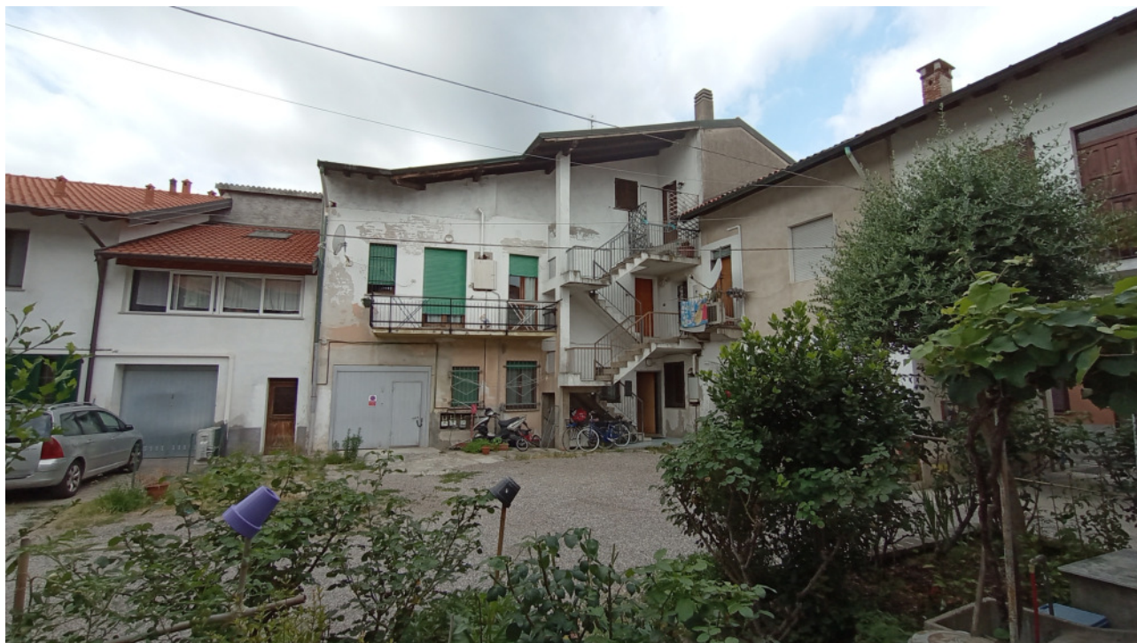
Cantina – accesso dal cortile interno
