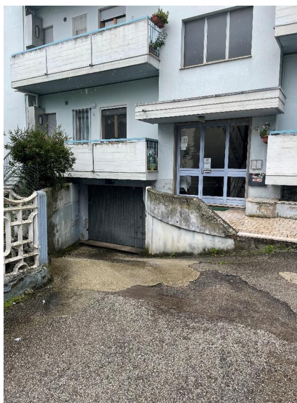
Foto N. 2 Rampa d'accesso e serranda
