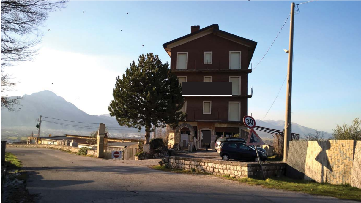
Foto n. 1 – prospetto sud est
