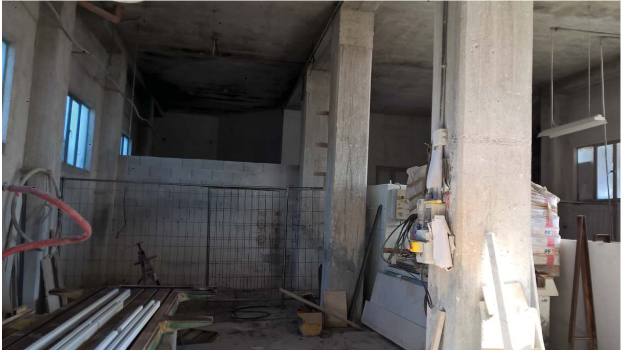
Foto n. 9 – interno locale piano seminterrato
