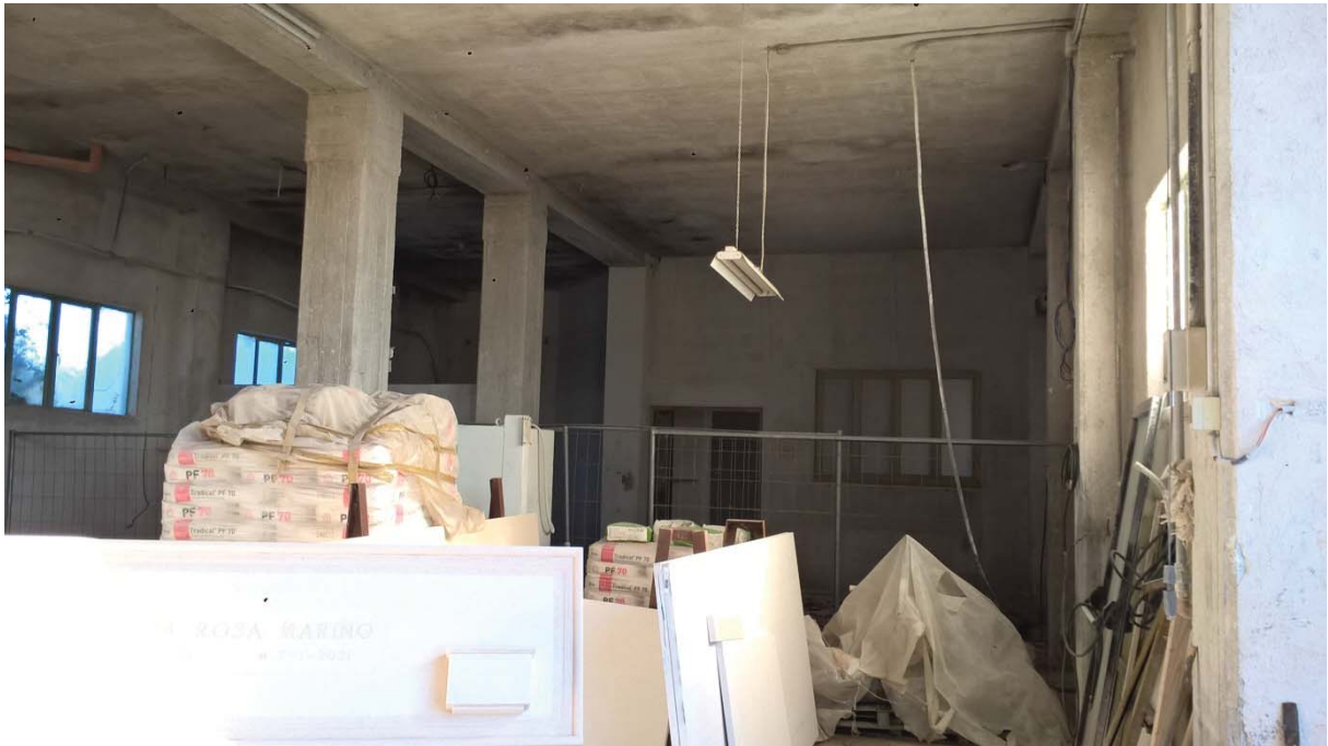
Foto n. 10 – interno locale piano seminterrato
