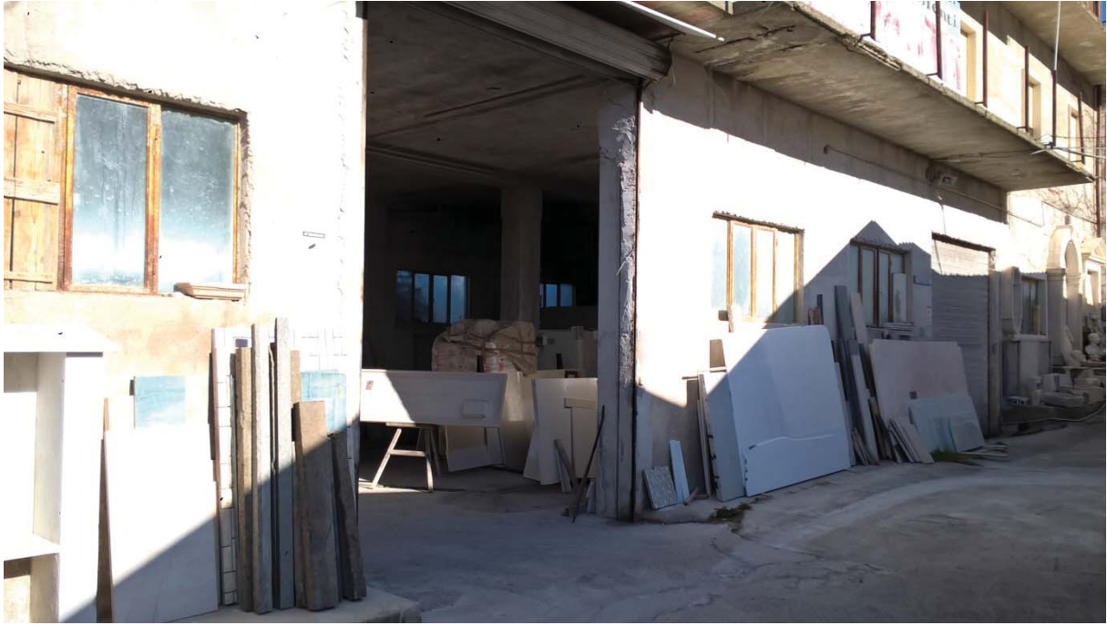
Foto n. 7 – ingresso al locale seminterrato
