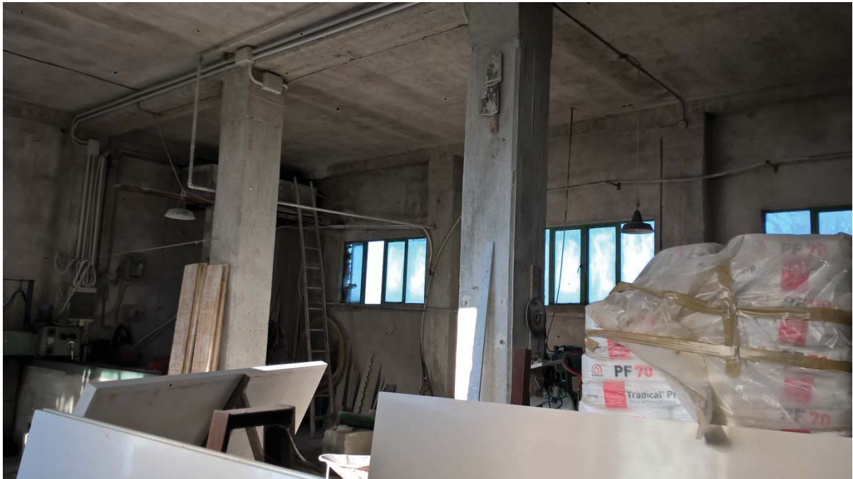
Foto n. 8 – interno locale piano seminterrato
