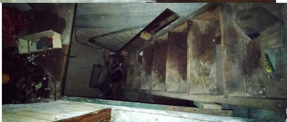
Foto 43-44 – botola e scala in legno di accesso a vano scantinato interrato
