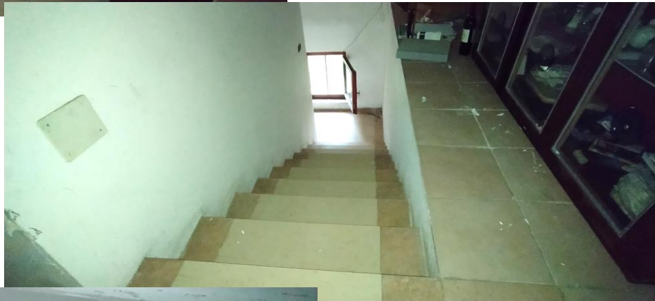
Foto 30-31-32 – Ingresso al sottotetto Piano Secondo
